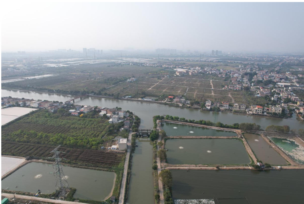
官佃水闸现状
