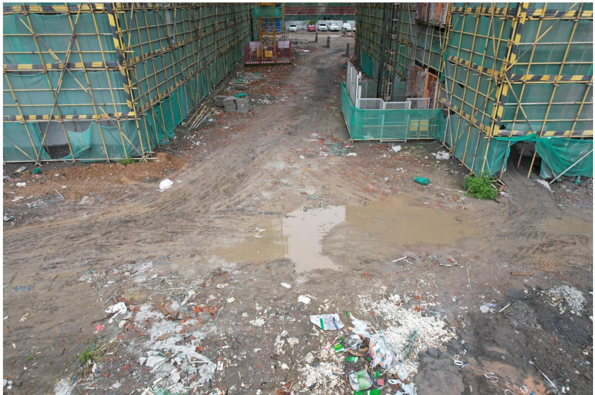
项目建设区中部现状
