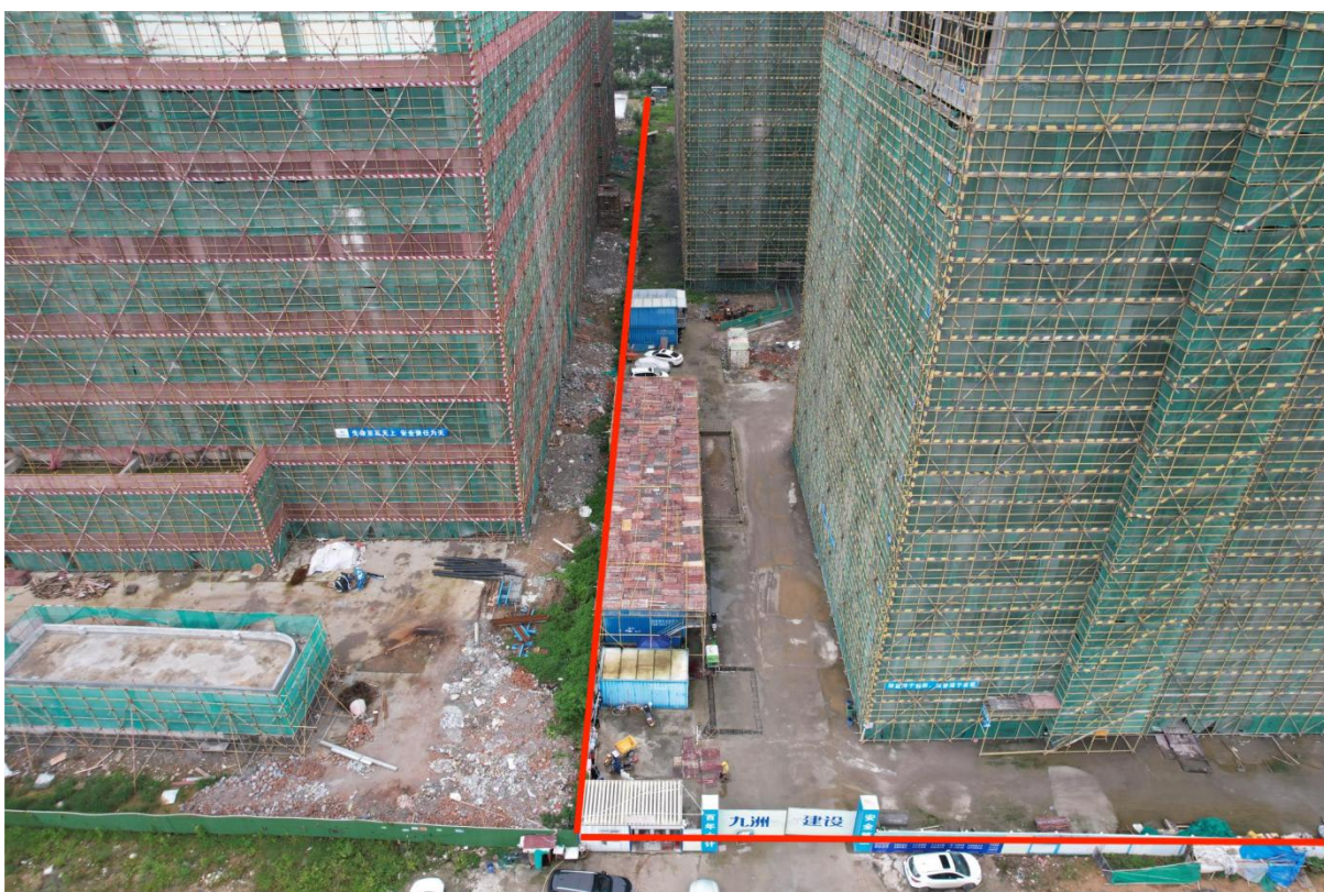
项目建设区与南侧在建厂房的现状
