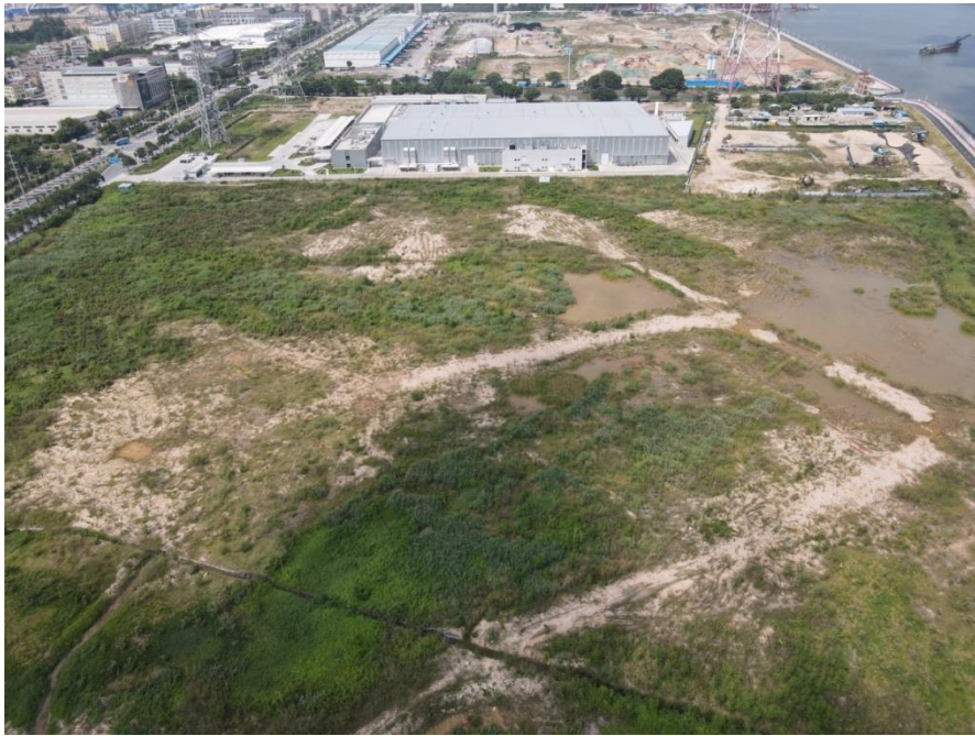
绿化、硬化区域（排水沟）
