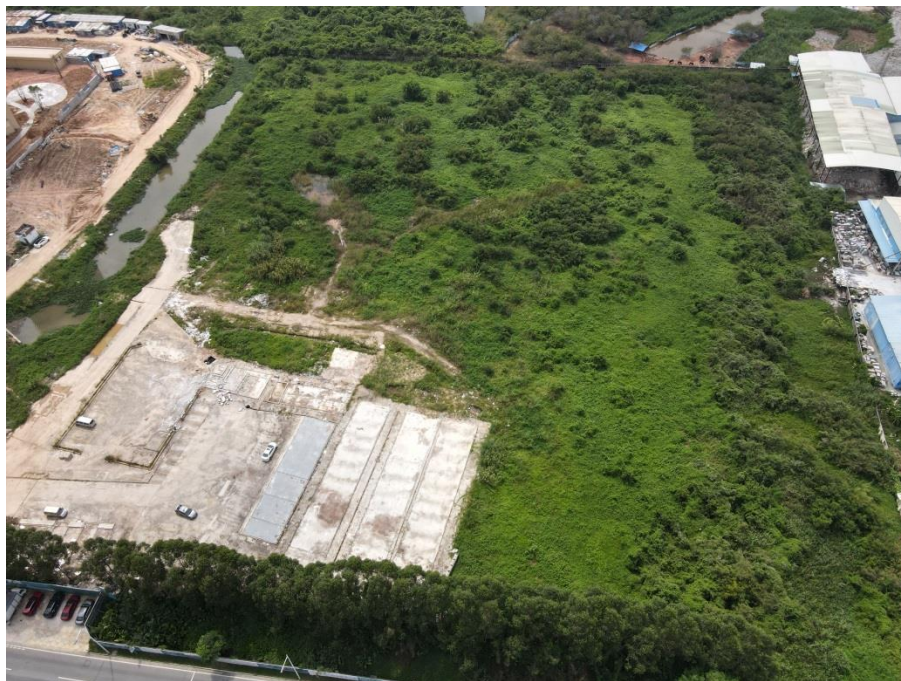
施工临建区（硬化）和临时堆土区（绿化）现状
