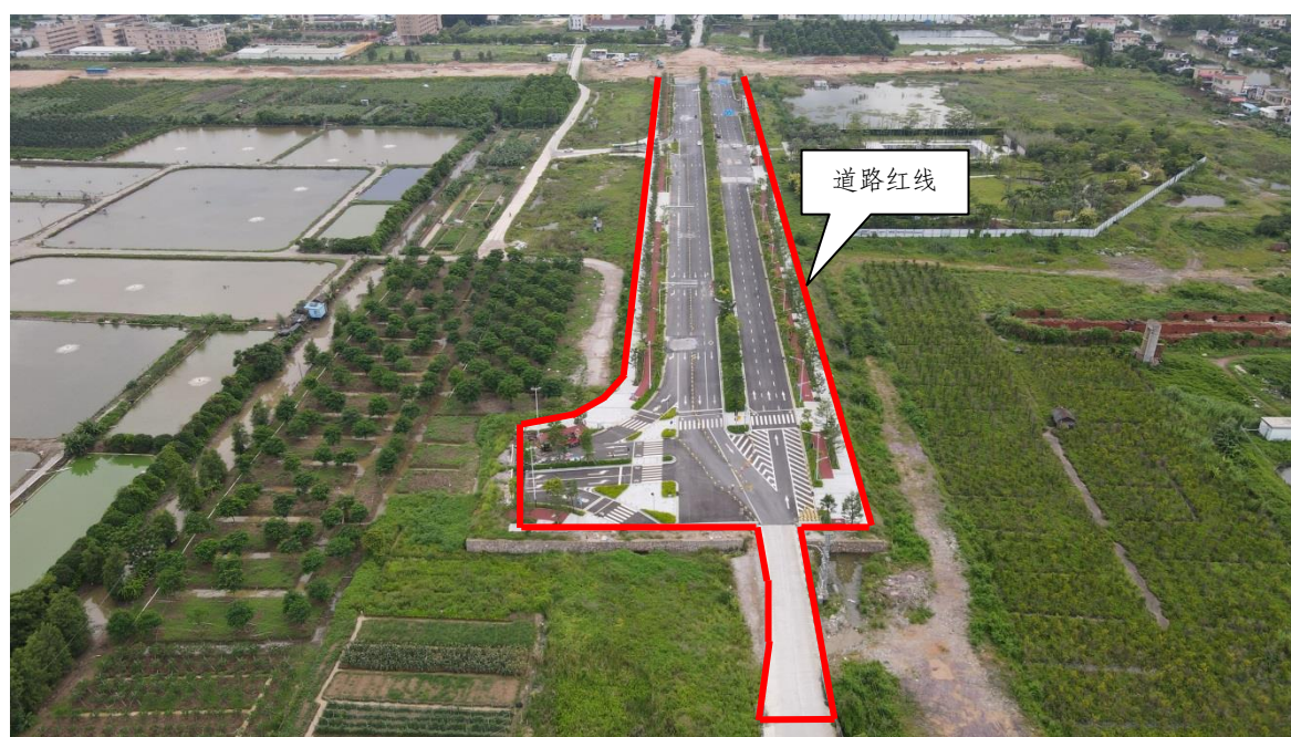
道路现状（东→西）
