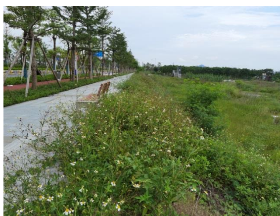
边坡喷播植草防护、临时占地撒播草籽
