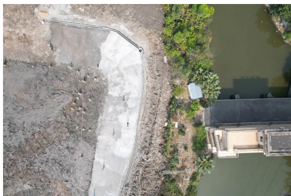
基坑顶部排水沟、沉沙池
