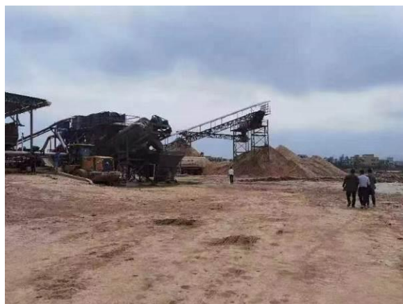
余方综合利用地现场照片二
