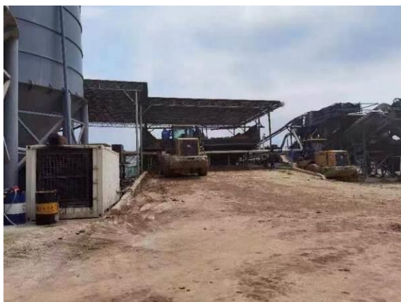
余方综合利用地现场照片一
