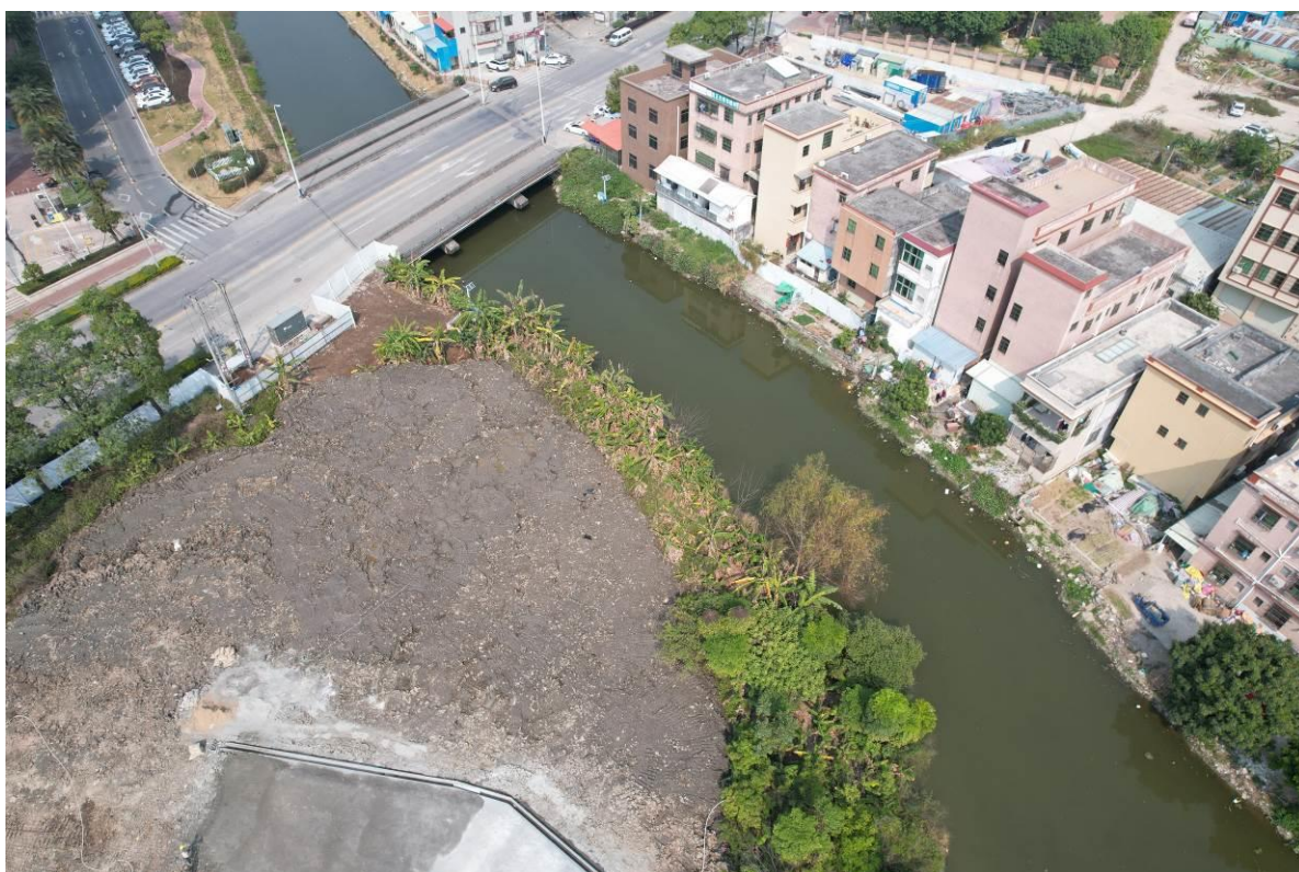
施工期东侧临时扰动现状
