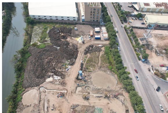
施工期西侧临时扰动现状
