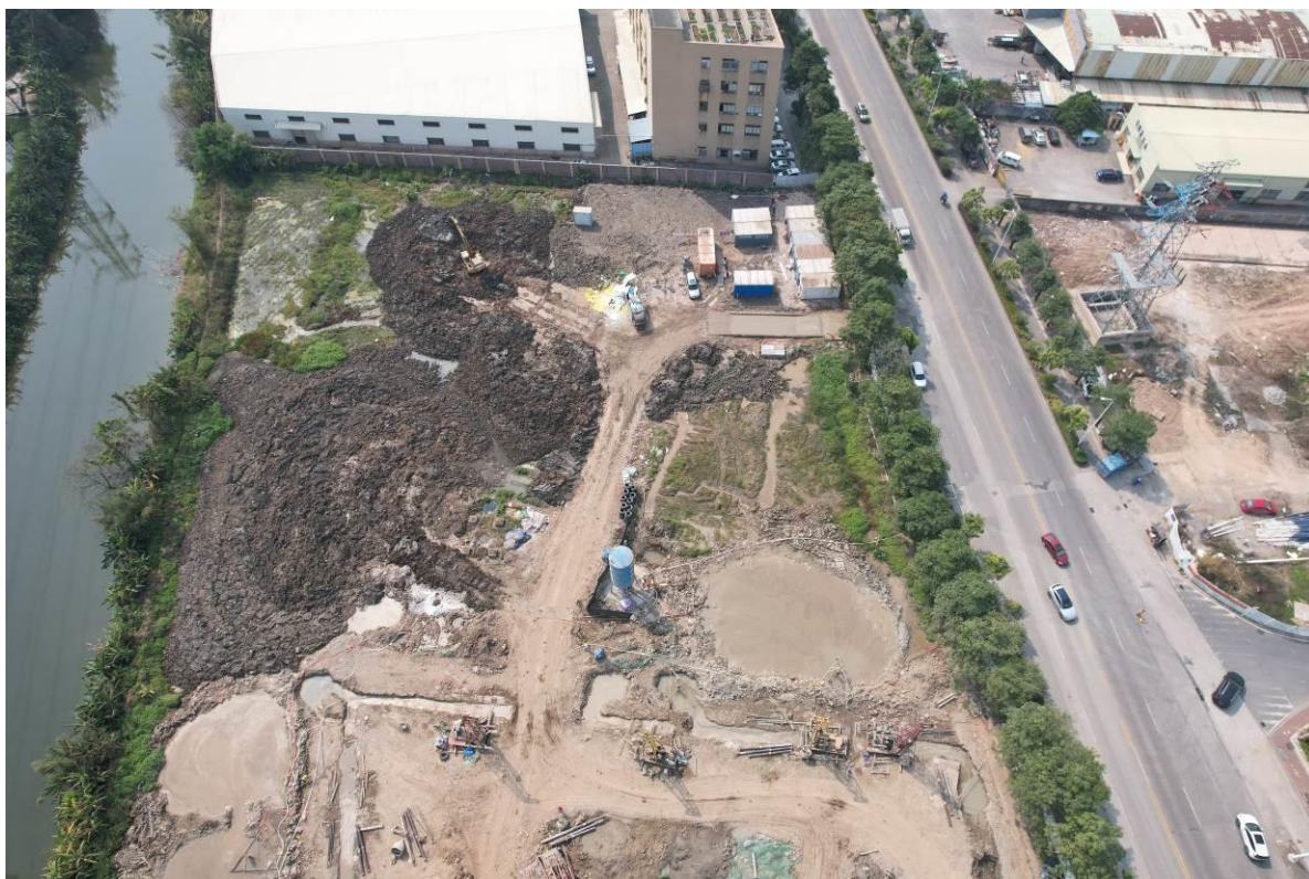
施工期西侧临时扰动现状
