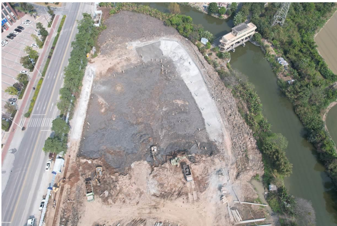
东侧施工现状
