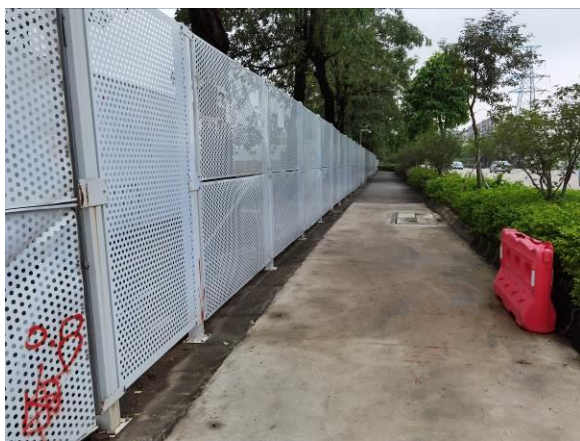
北侧木河迳东路施工围蔽现状
