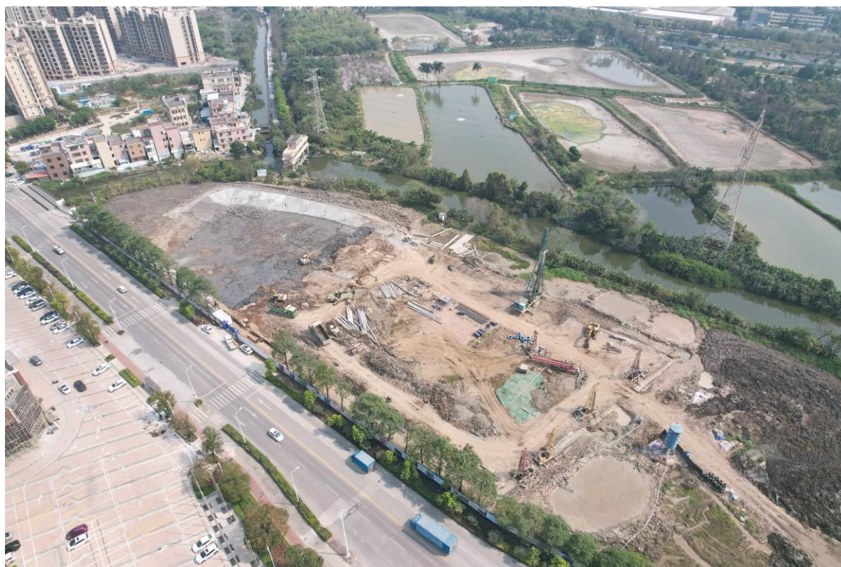
项目施工现状
