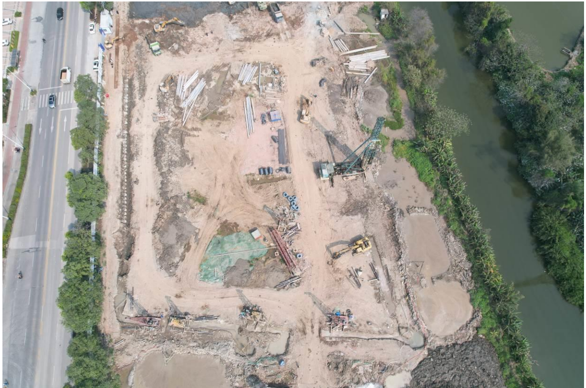
西侧施工现状
