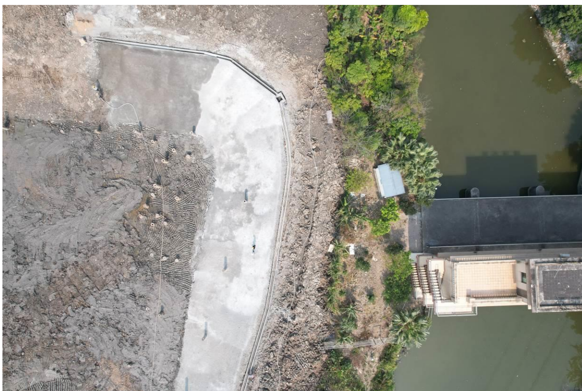
基坑顶部排水沟、沉沙池
