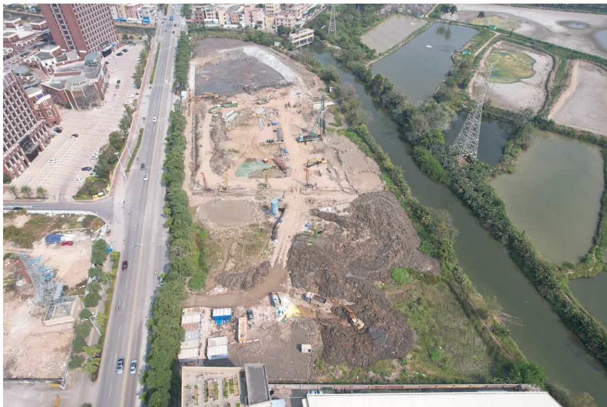
项目施工现状
