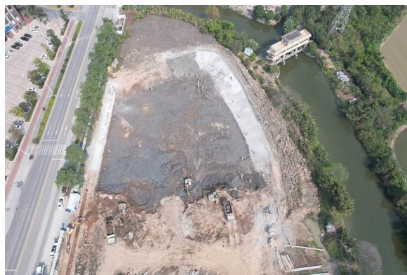
东侧施工现状
