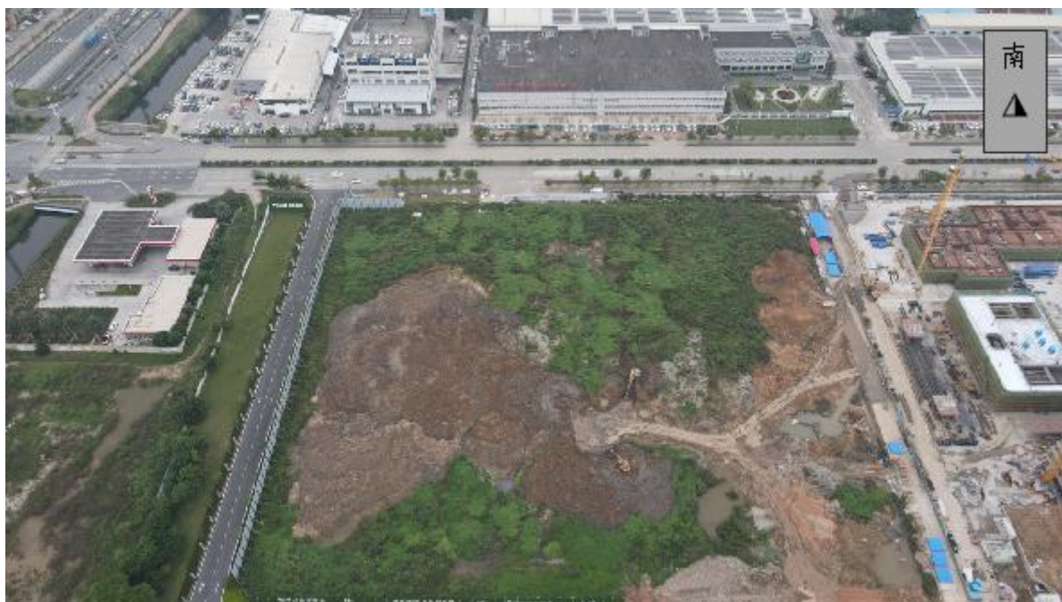
项目区由北向南（航拍）
