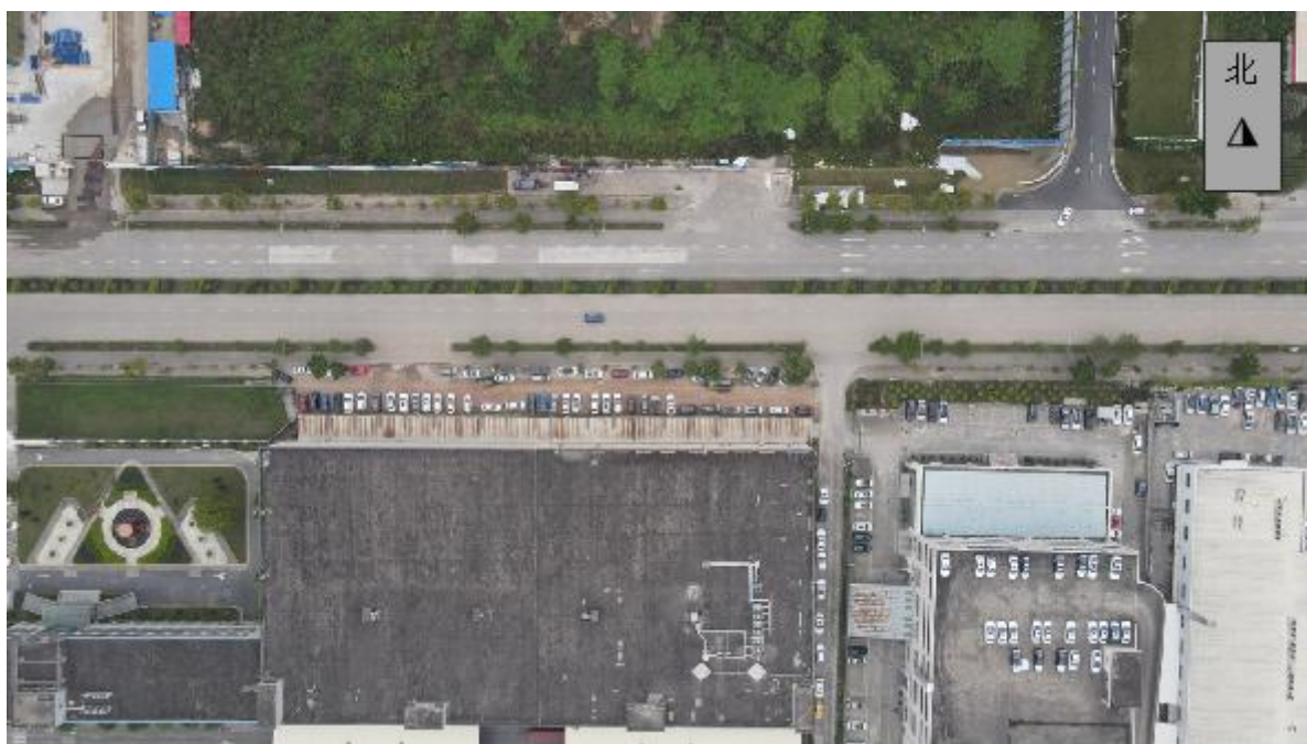
项目区南边建筑物（航拍）
