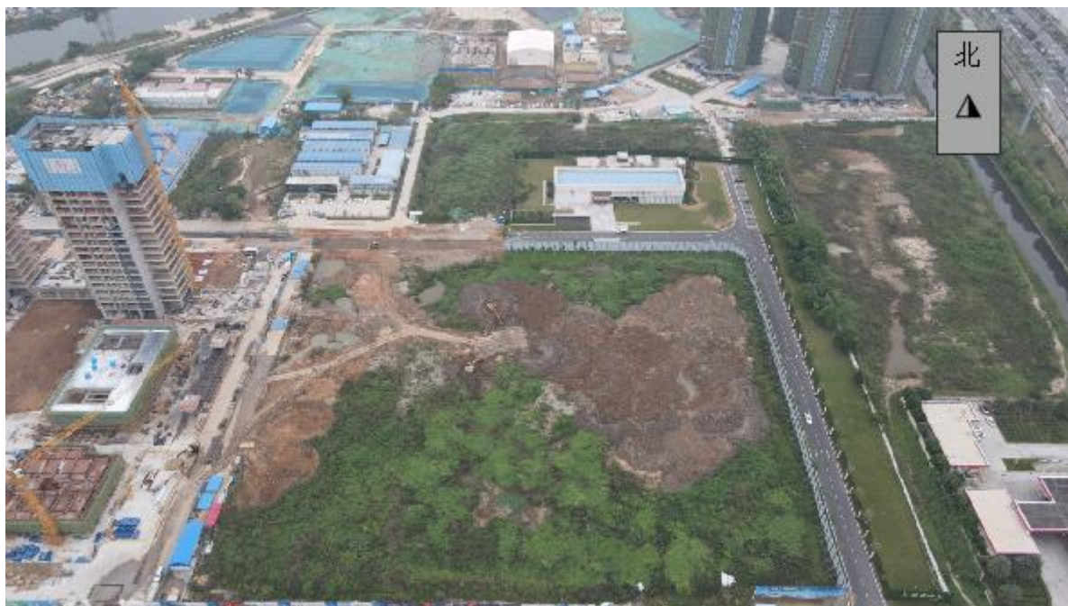
项目区由南向北边（航拍）
