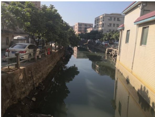
上坝九涌水闸内河涌连接段
