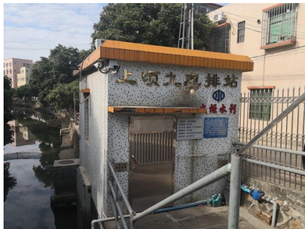
上坝九涌现状电排站
