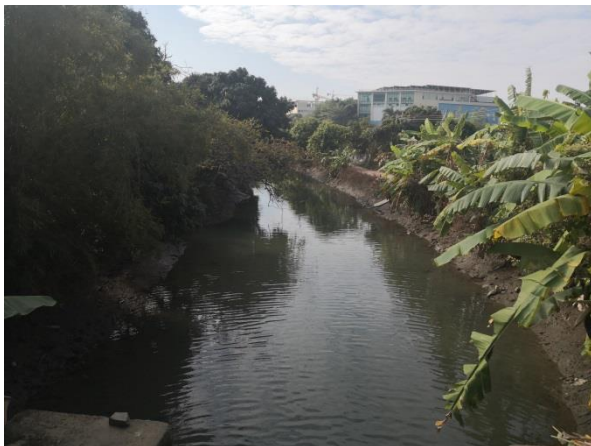
水洲涌水闸内河涌连接段
