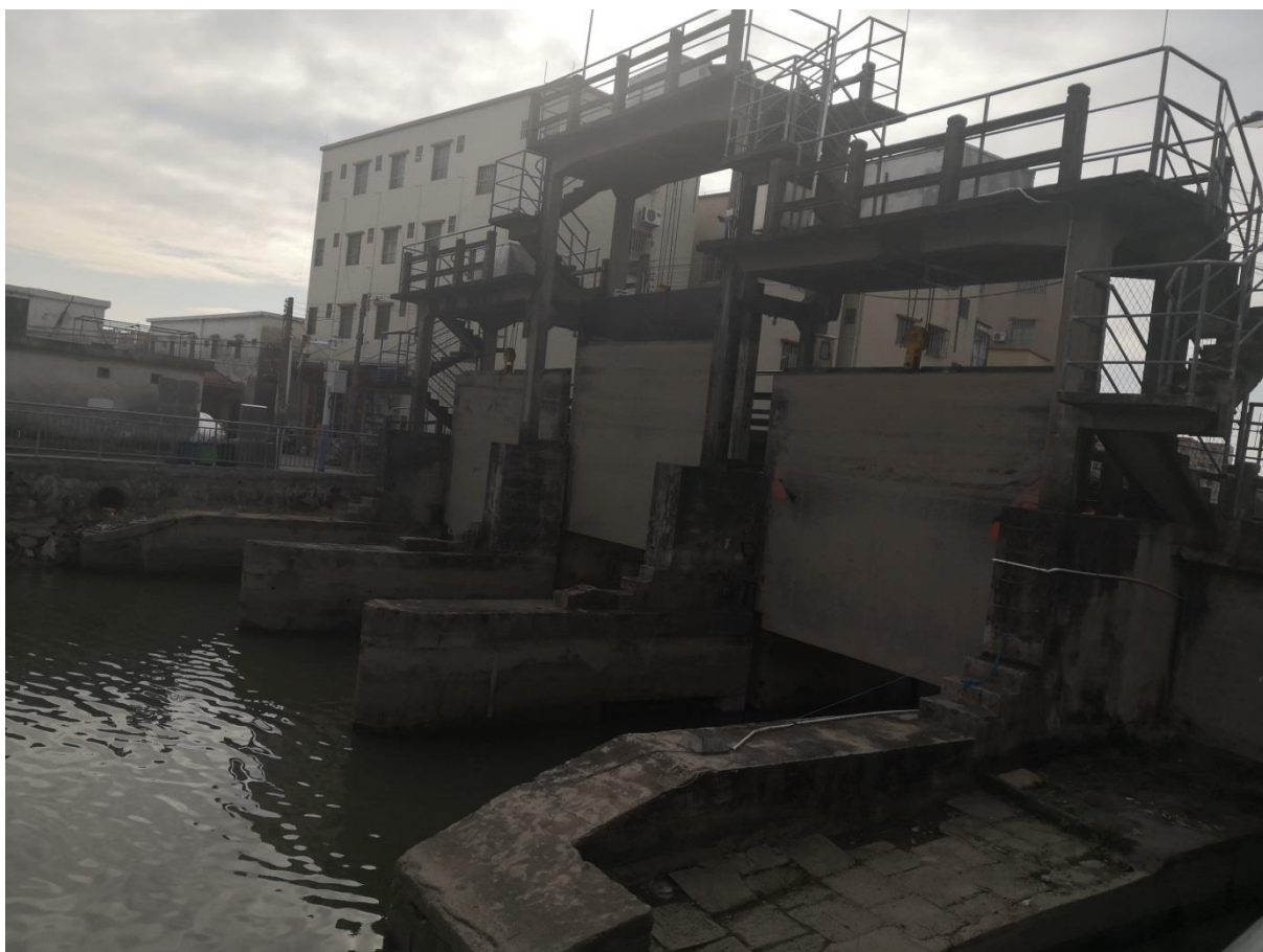
濠头涌水闸启闭平台
