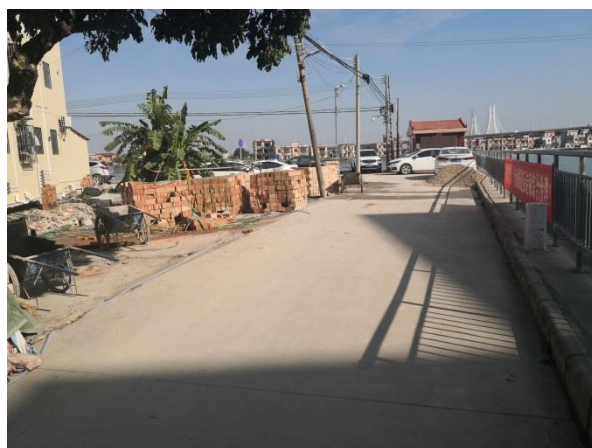
下坝九涌水闸堤顶施工临时道路
