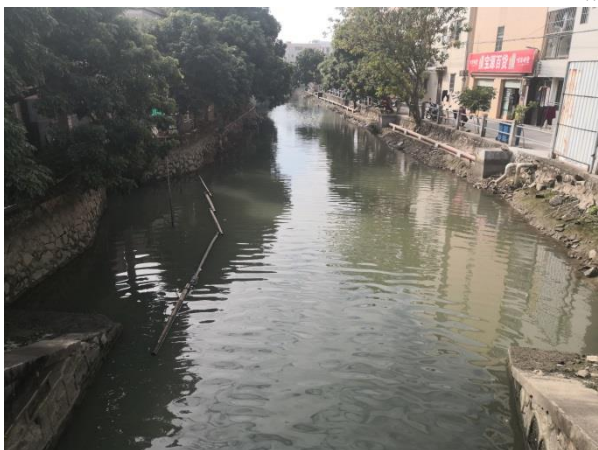
三涌水闸内河涌连接段
