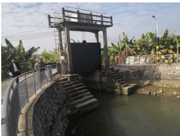
水洲涌水闸启闭平台
