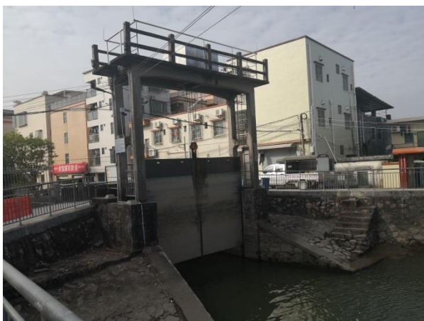
三涌水闸启闭平台
