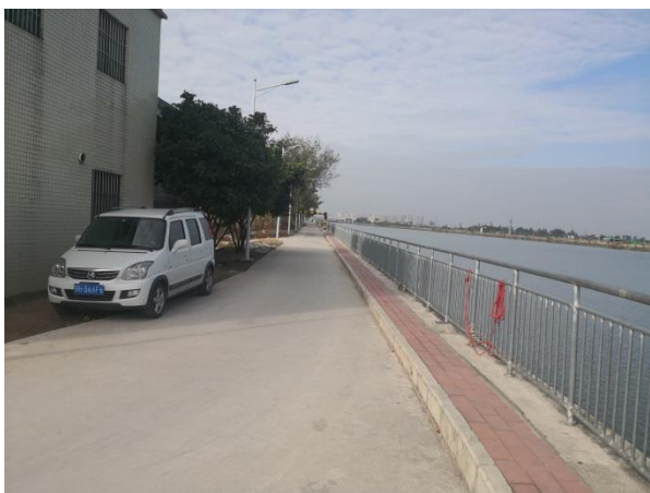
三涌水闸堤顶施工临时道路
