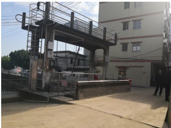
上坝九涌水闸启闭平台
