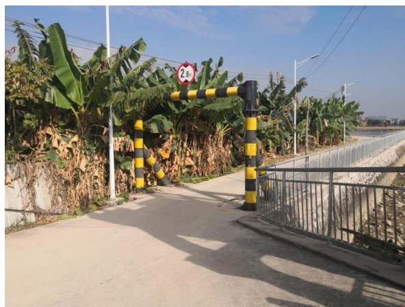
水洲涌水闸堤顶施工临时道路
