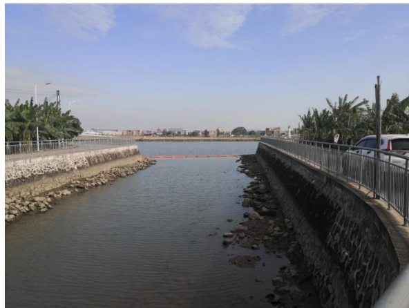
水洲涌水闸外江连接段
