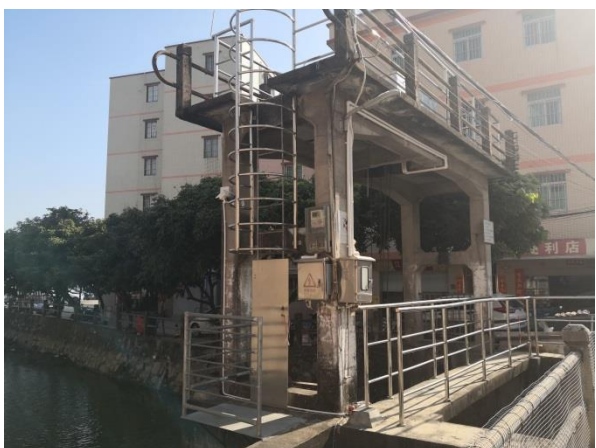
下坝九涌水闸启闭平台
