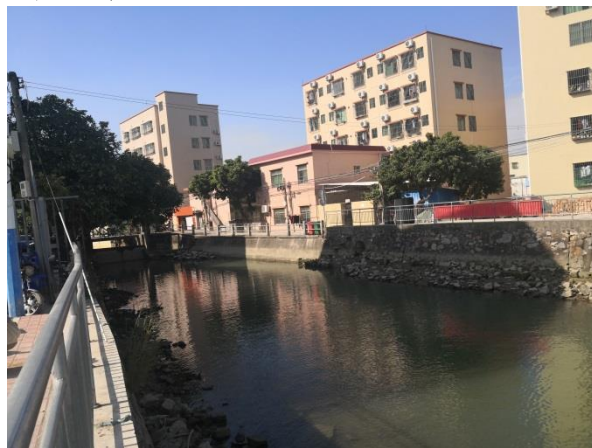
下坝九涌水闸外江连接段
