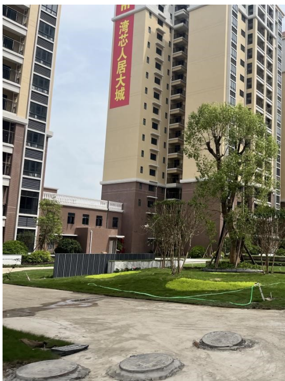
硬化道路及排水管网
