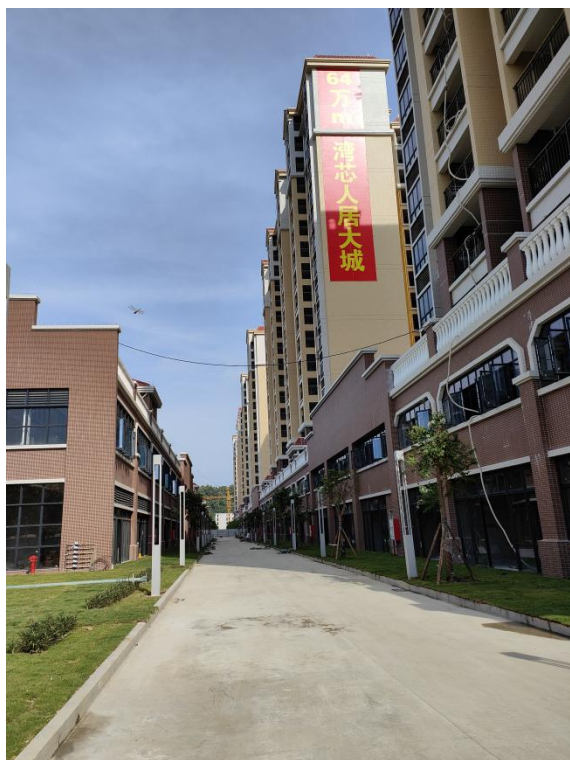
硬化道路及两旁绿化
