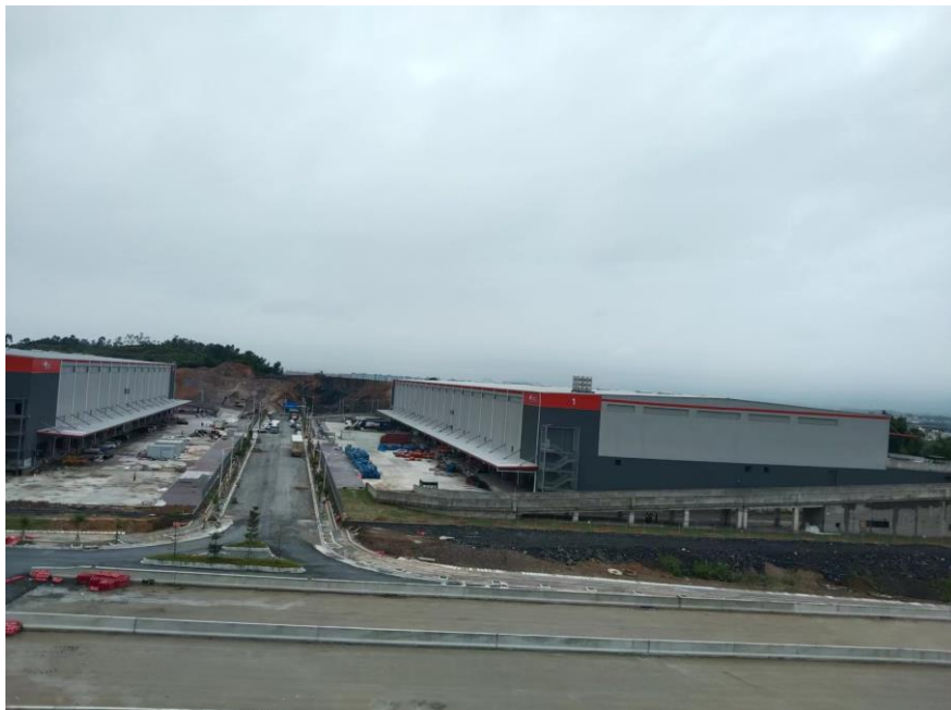
项目场地中间代征道路区
