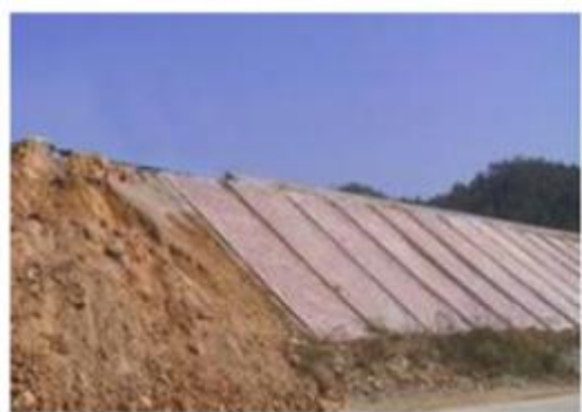
北江大堤施工期塑料薄膜防护
