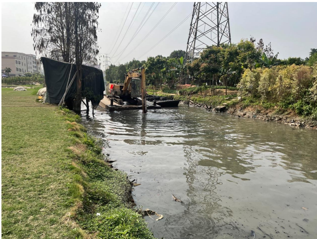
东沥涌现状情况（二）
