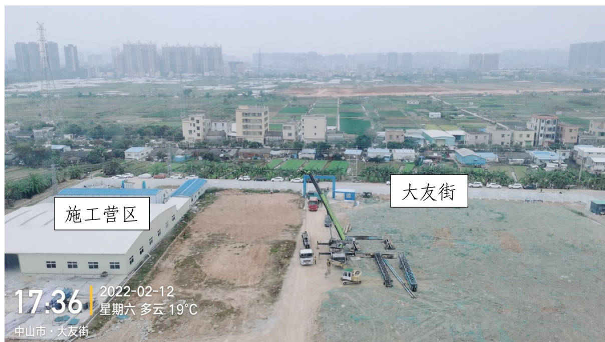
施工营区及现状裸露地表
