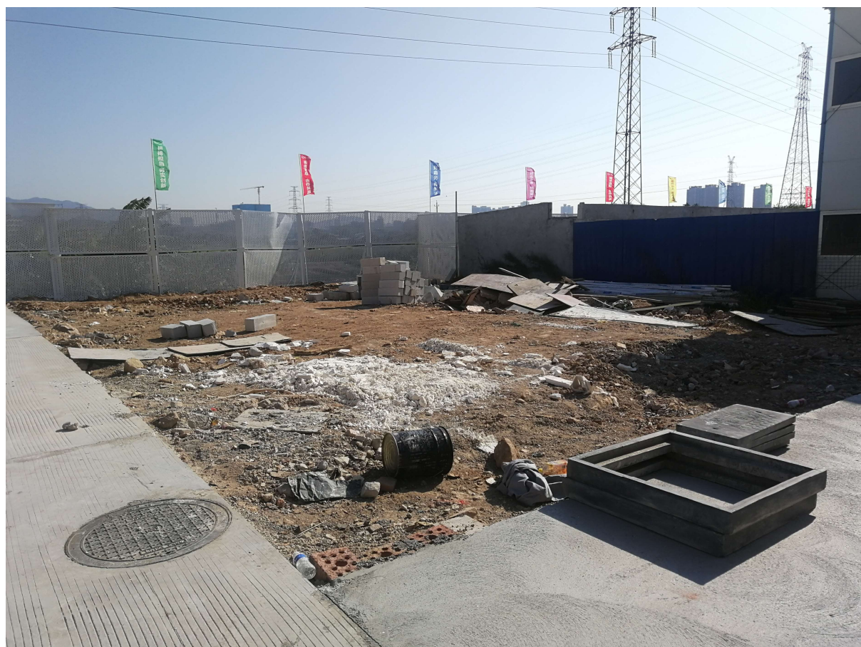
施工营区旁裸露地表
