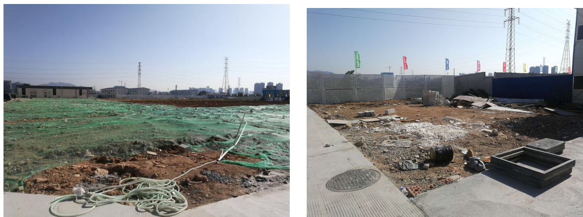
图 1-1 本工程施工建设情况
