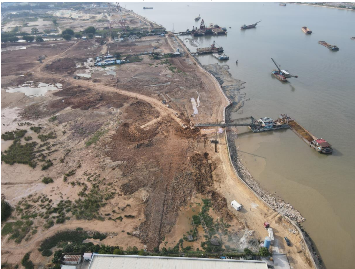
项目北侧土方运送及回填现状
