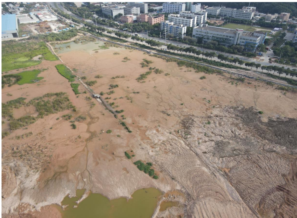
项目东南侧现状
