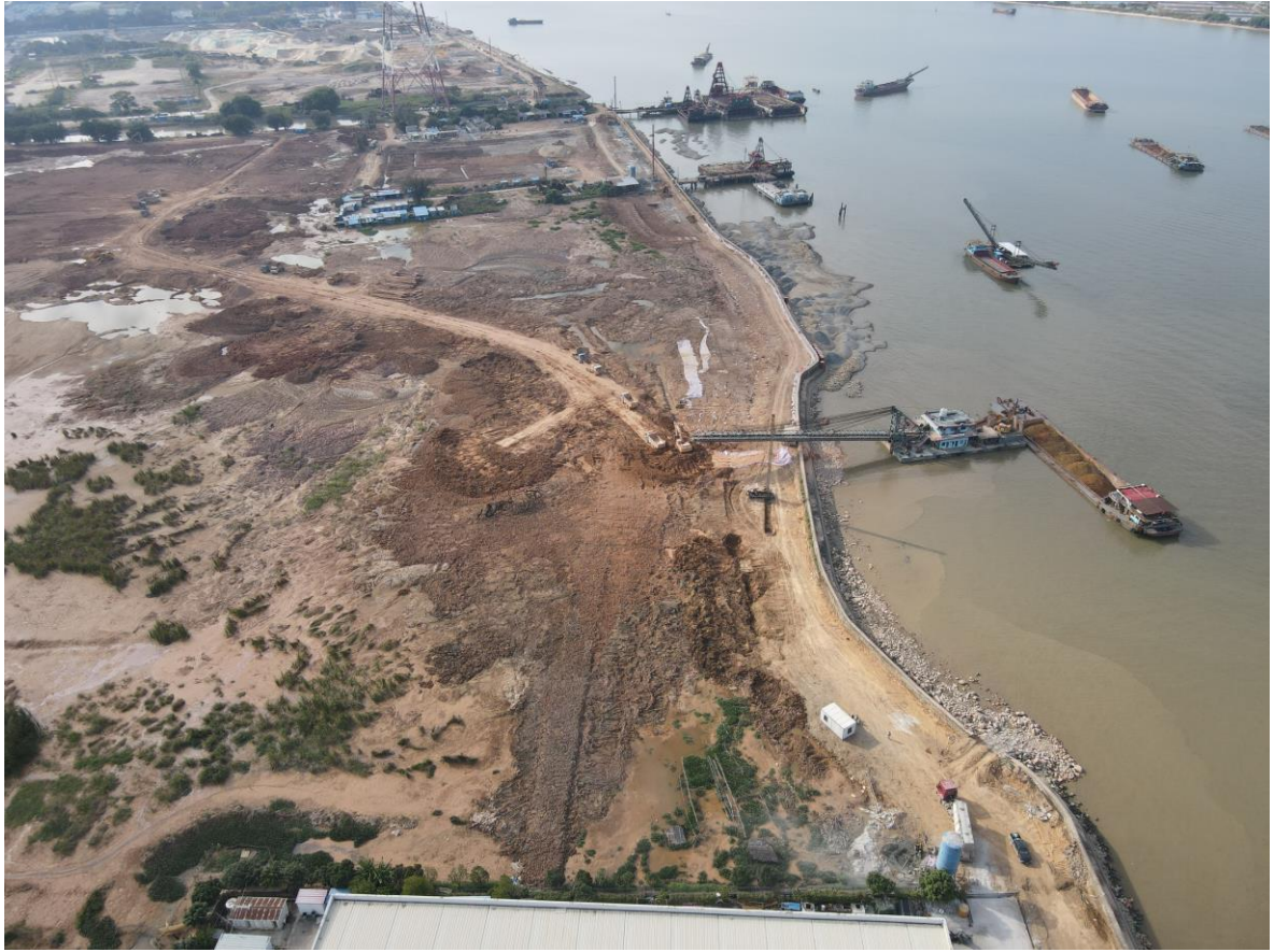
项目北侧土方运送及回填现状
