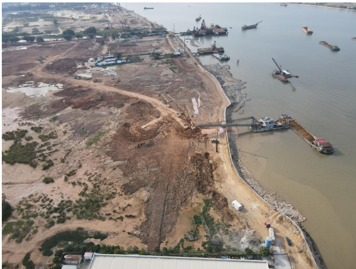
项目北侧土方运送及回填现状
