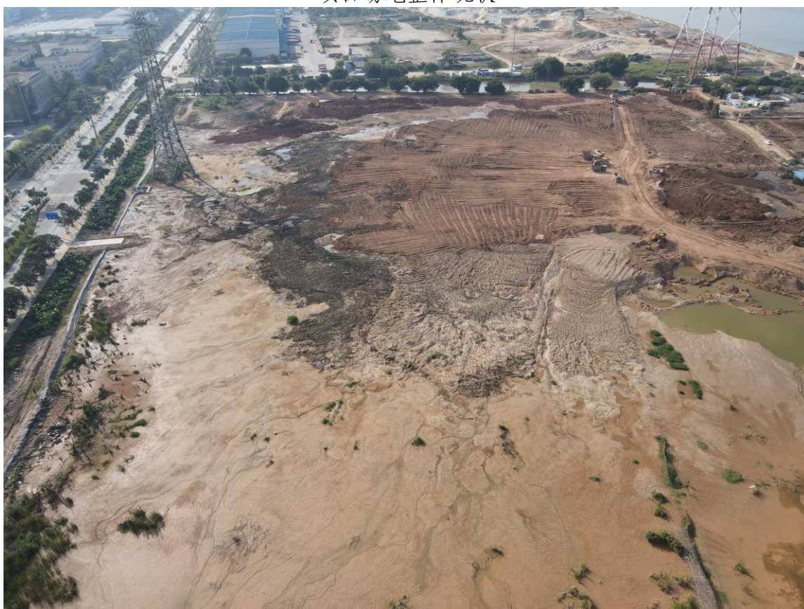
项目西南侧回填现状
