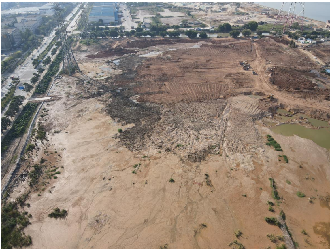
项目西南侧回填现状
