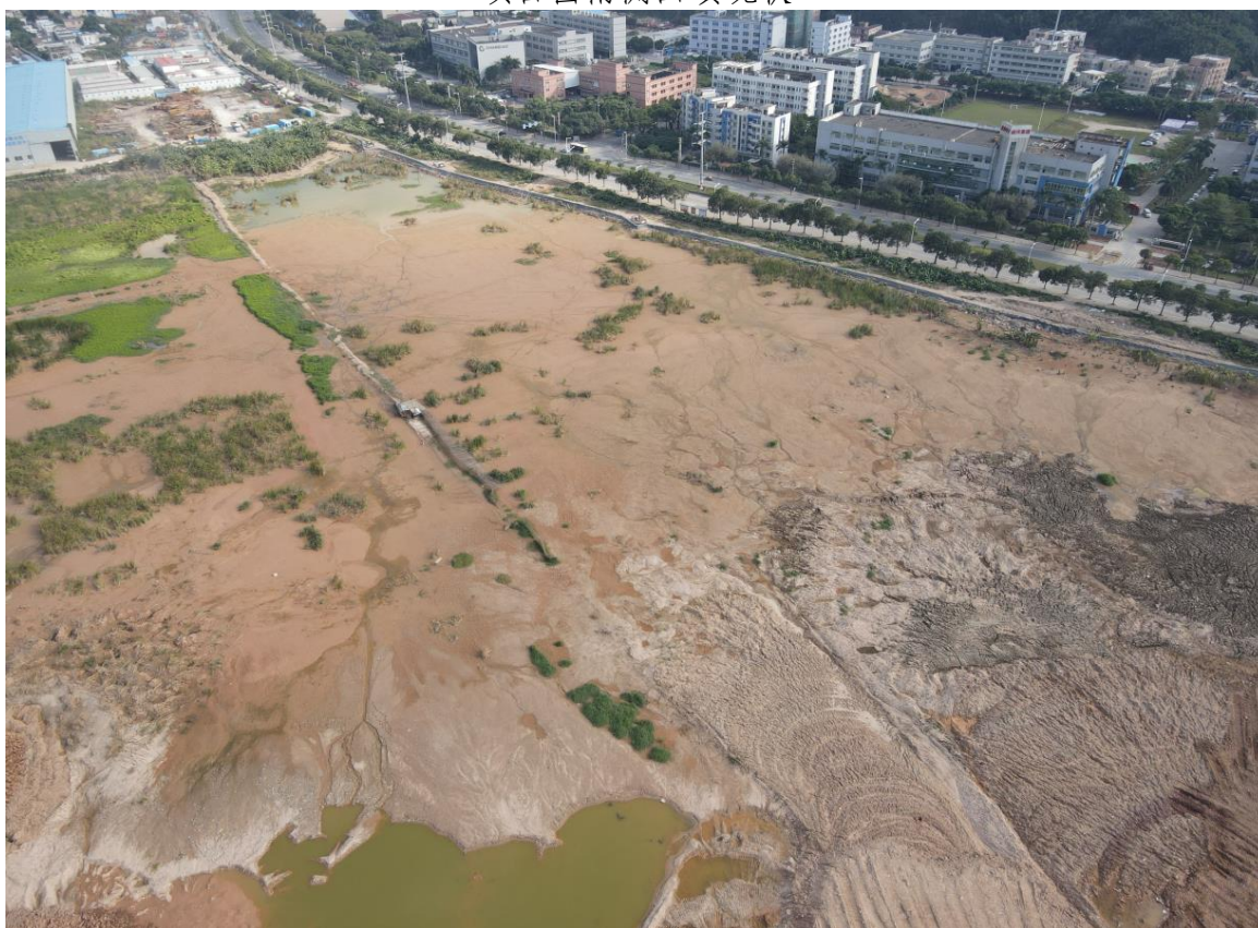
项目东南侧现状
