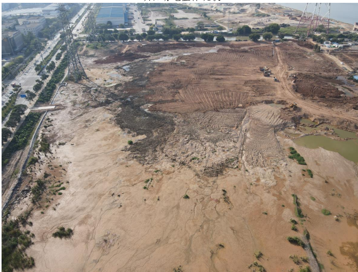
项目西南侧回填现状
