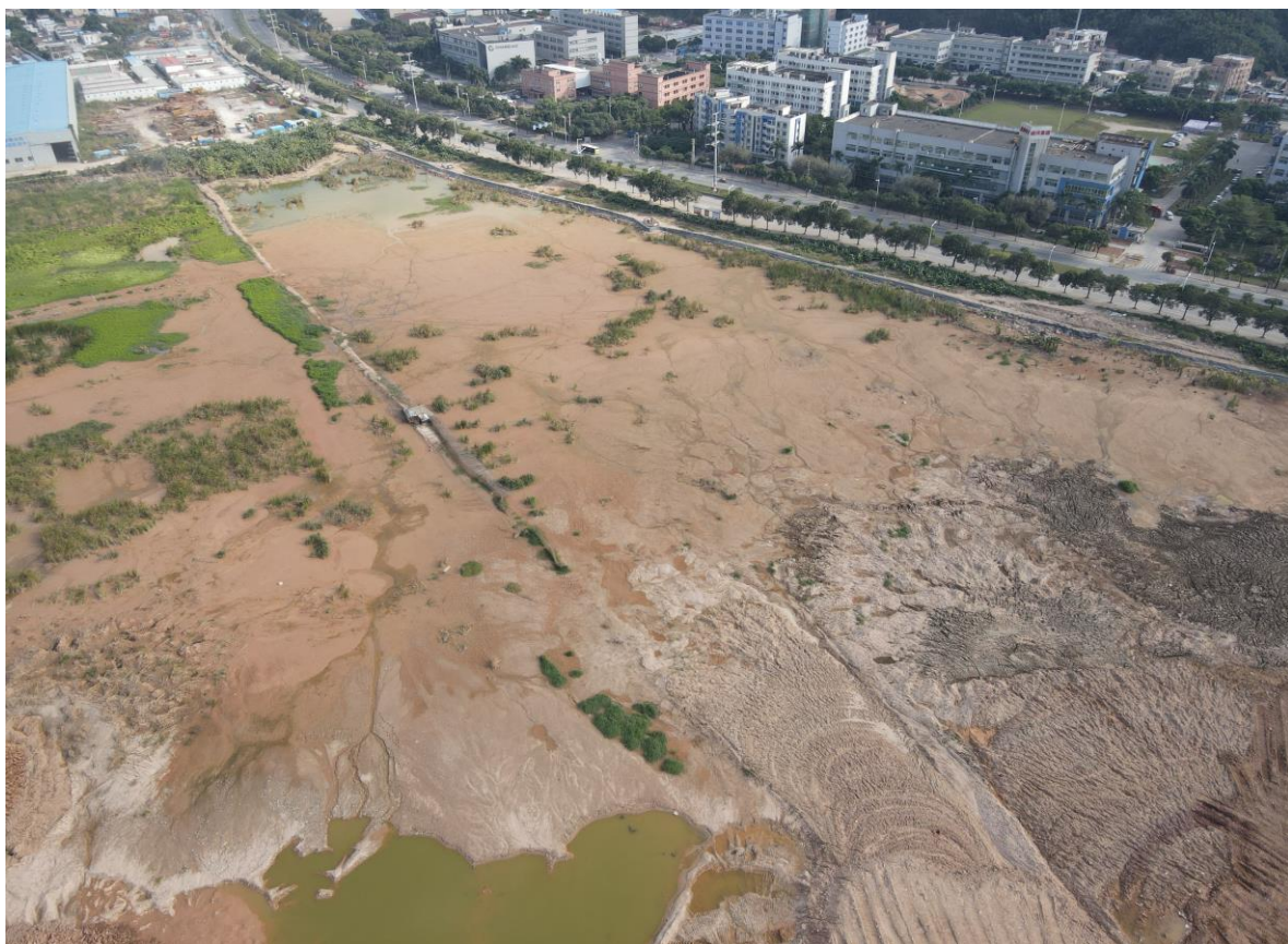
项目东南侧现状
