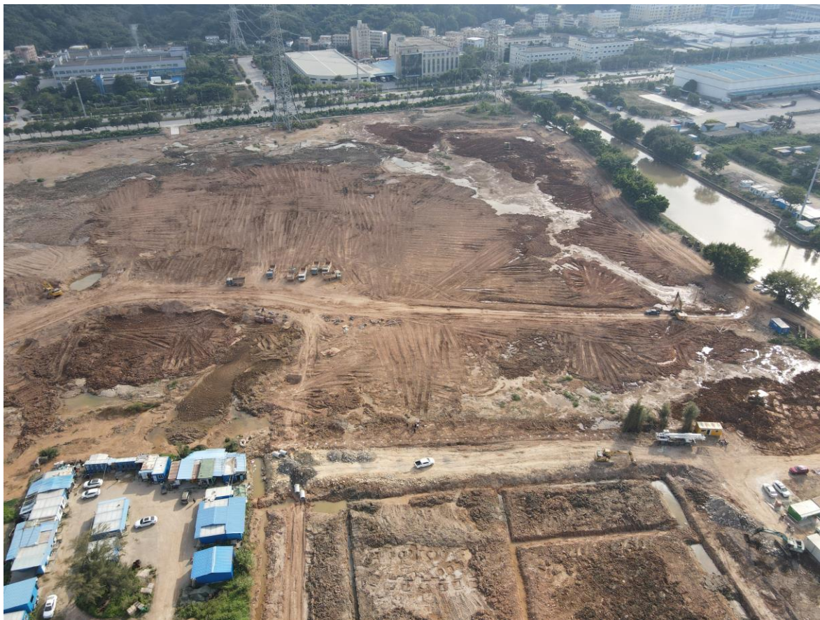
项目西侧回填现状
