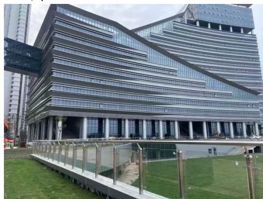
建构筑物现状
