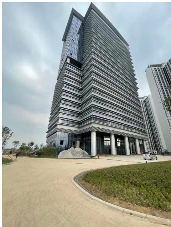
建构筑物现状
