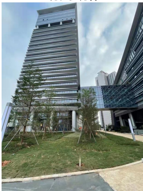
建构筑物现状
