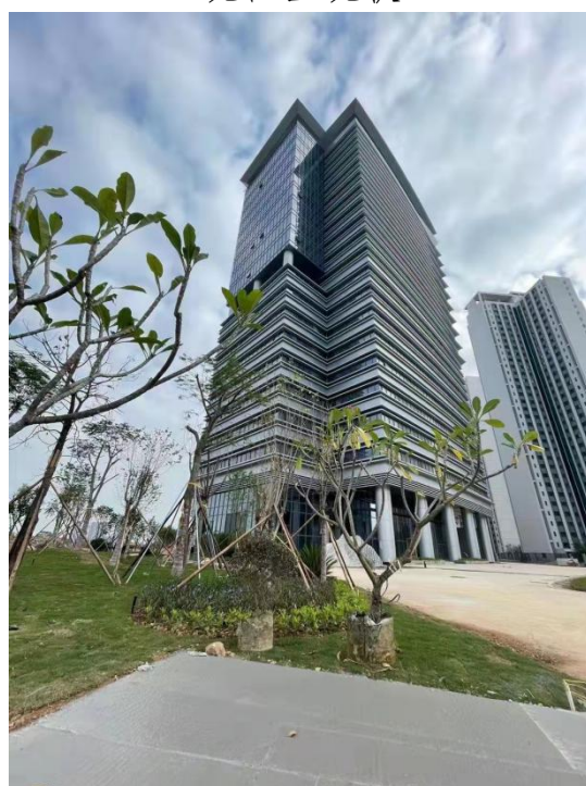
建构筑物现状
