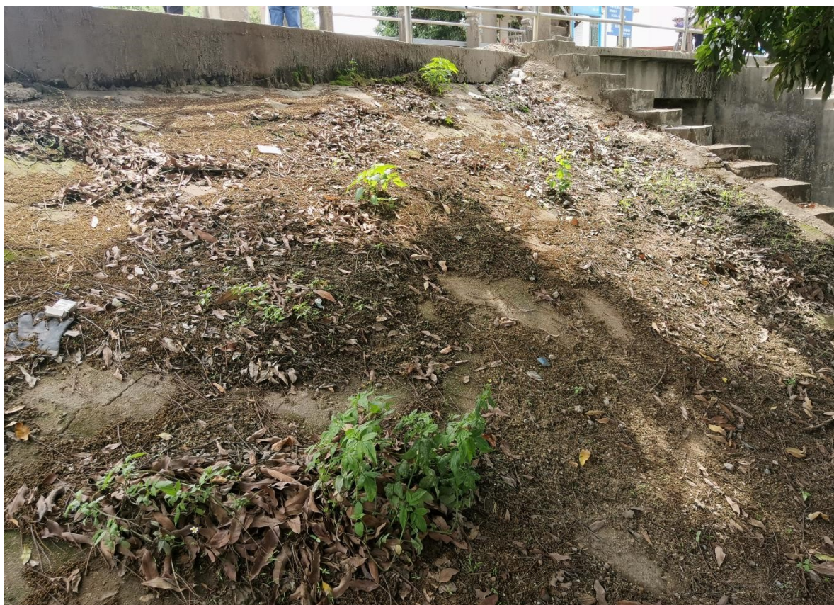
水闸下游砼护坡
