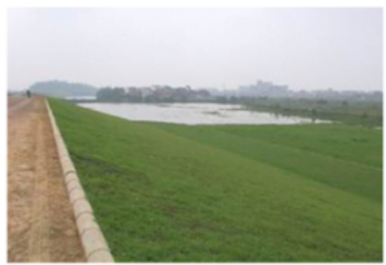
北江大堤施工结束效果图
