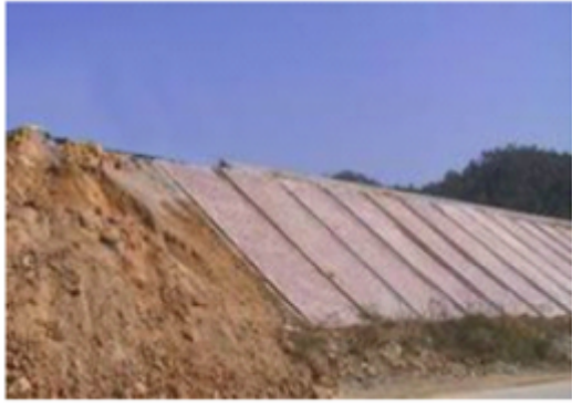
北江大堤施工期塑料薄膜防护
