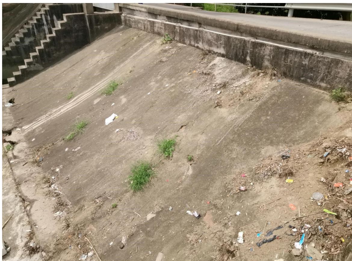
水闸上游砼护坡
