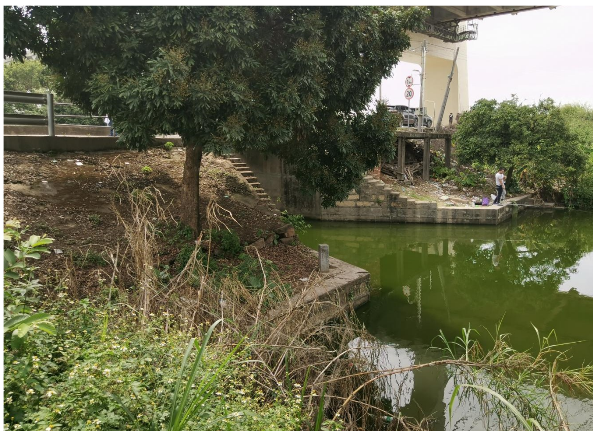
上南南水闸内河连接段
