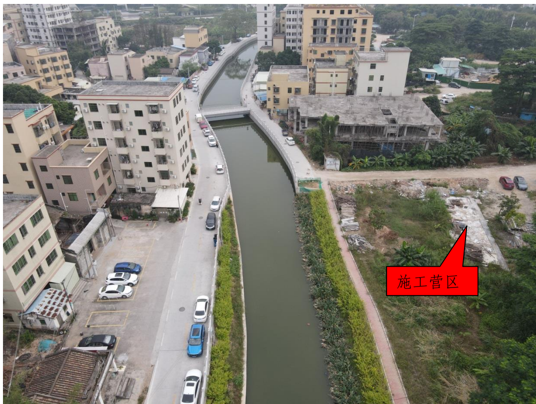
火炬开发区下岐涌整治工程（K1+239~K1+528 段）航拍图
