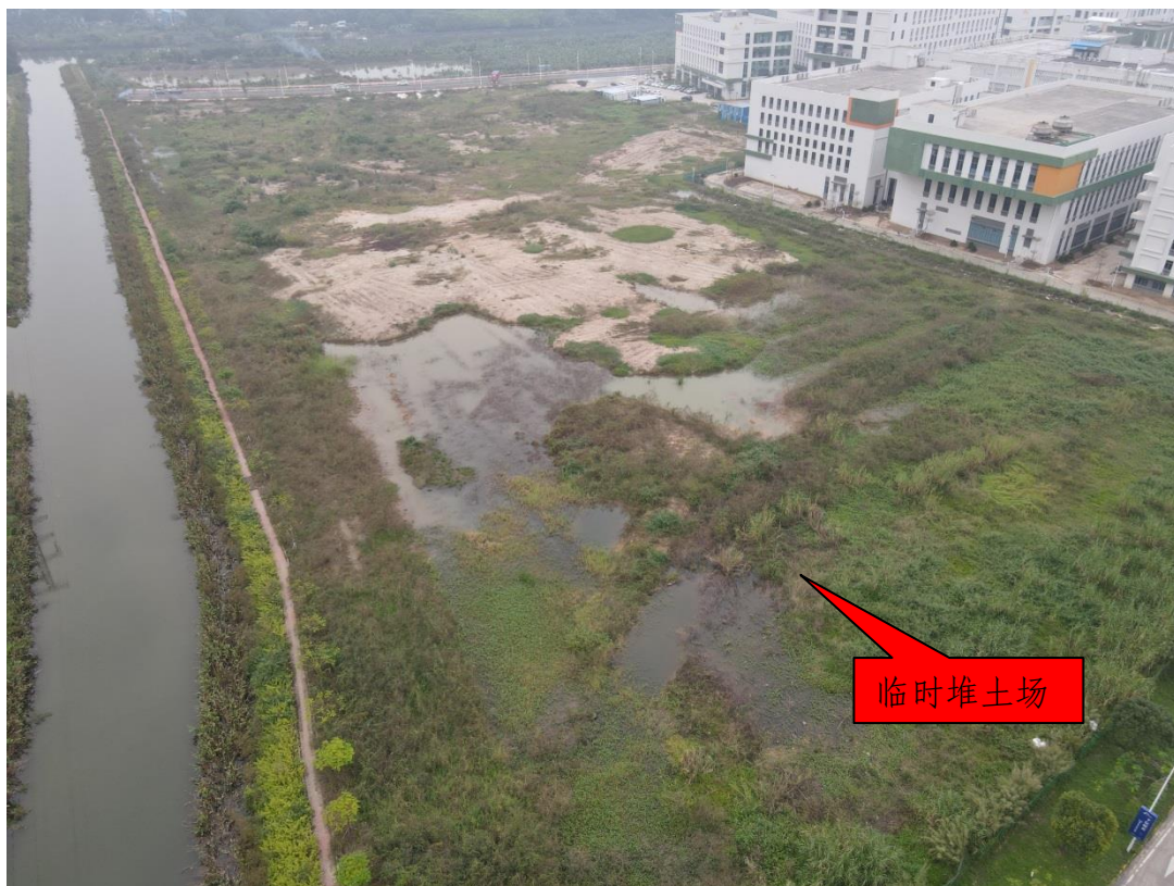
火炬开发区下岐涌整治工程（临时堆土场）航拍图
