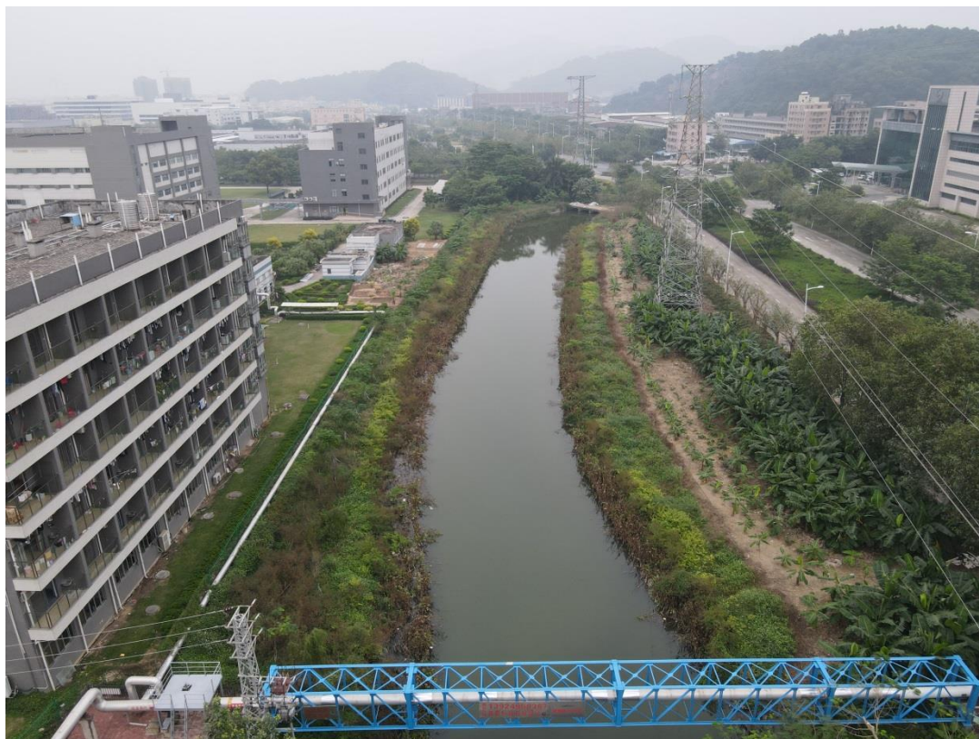
火炬开发区下岐涌整治工程（K0+571~K0+770 段）航拍图
