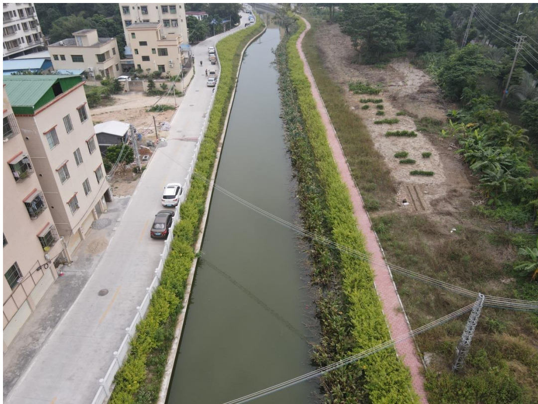
火炬开发区下岐涌整治工程（K0+997~K1+239 段）航拍图
