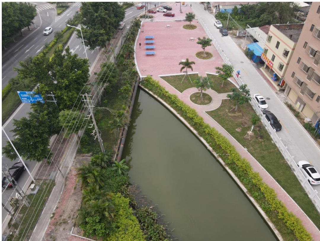
火炬开发区下岐涌整治工程（休闲中心）航拍图
