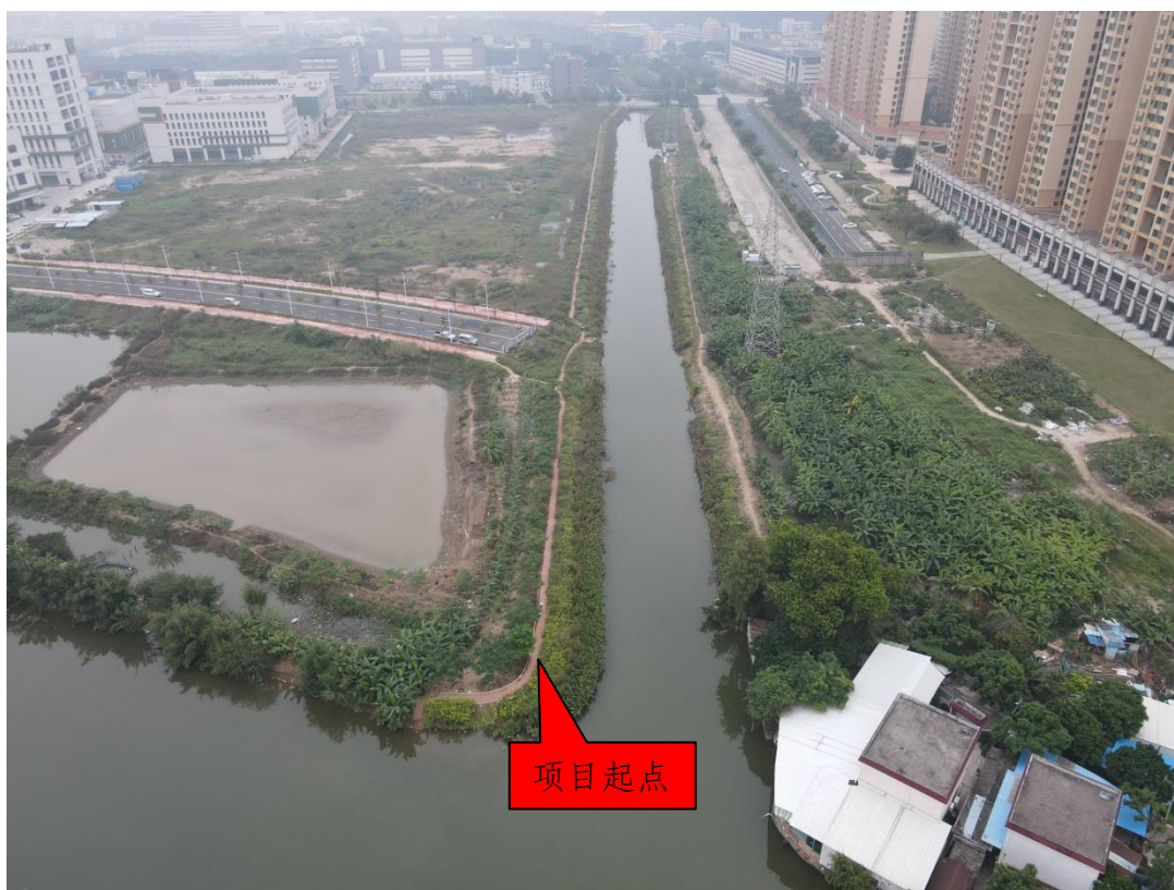
火炬开发区下岐涌整治工程（K0+000~K0+528 段）航拍图
