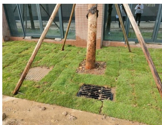
建筑物周边绿化及排水
