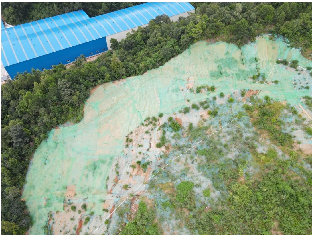
边坡 A 情况
