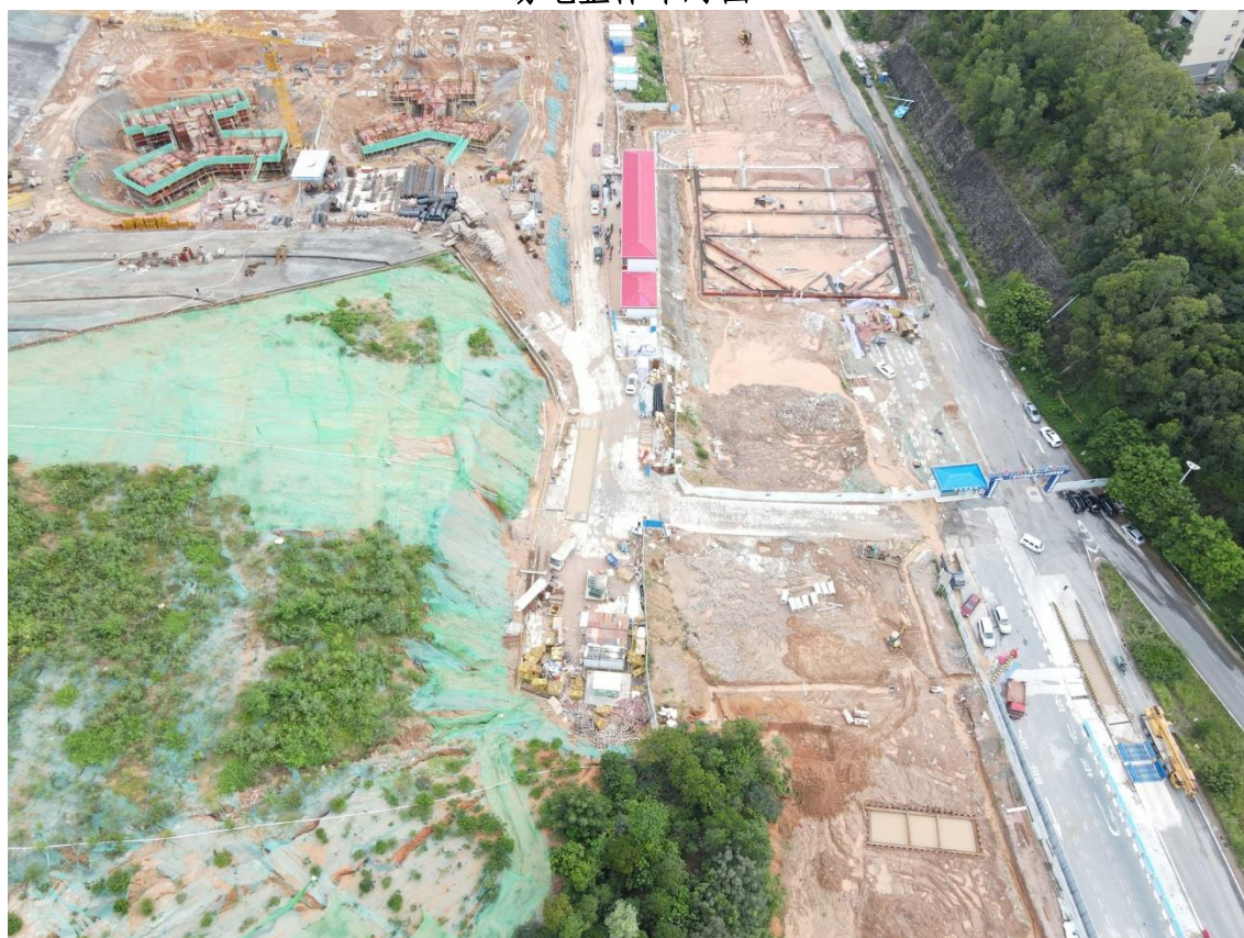
边坡 C、硬化区域及西侧中山至开平高速公路施工现场（南外环路）
