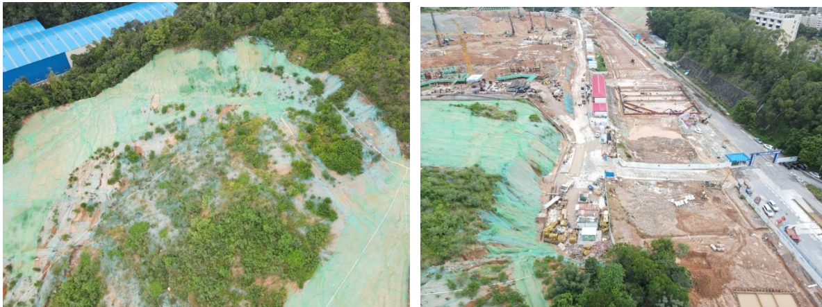
东侧边坡情况 (A 和 B 边坡)
