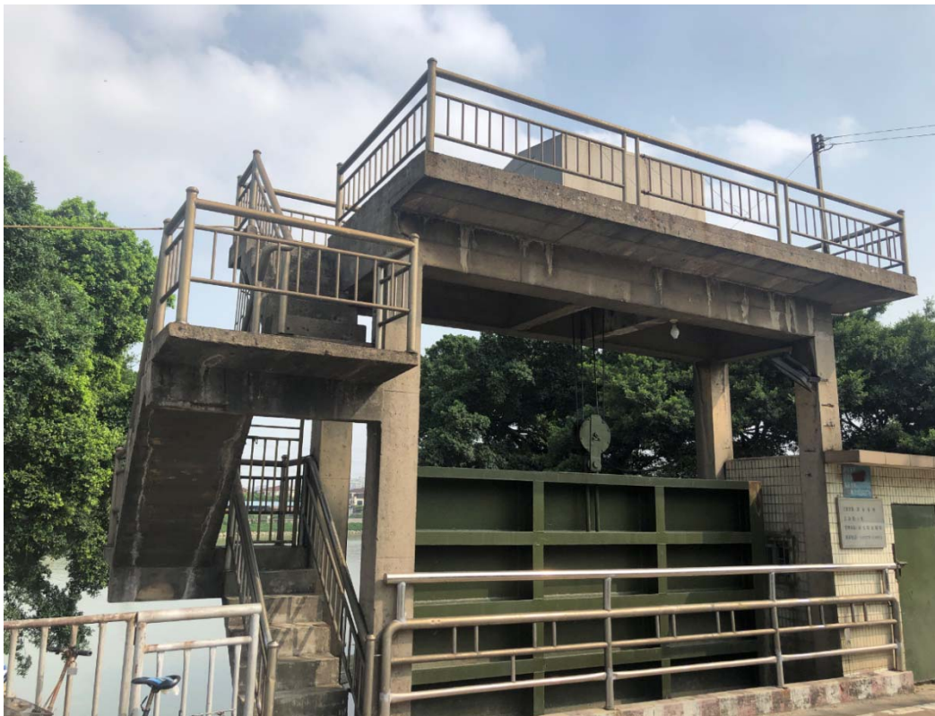
汲水水闸启闭平台
