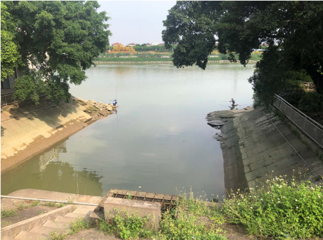
汲水泵站水闸外江连接
