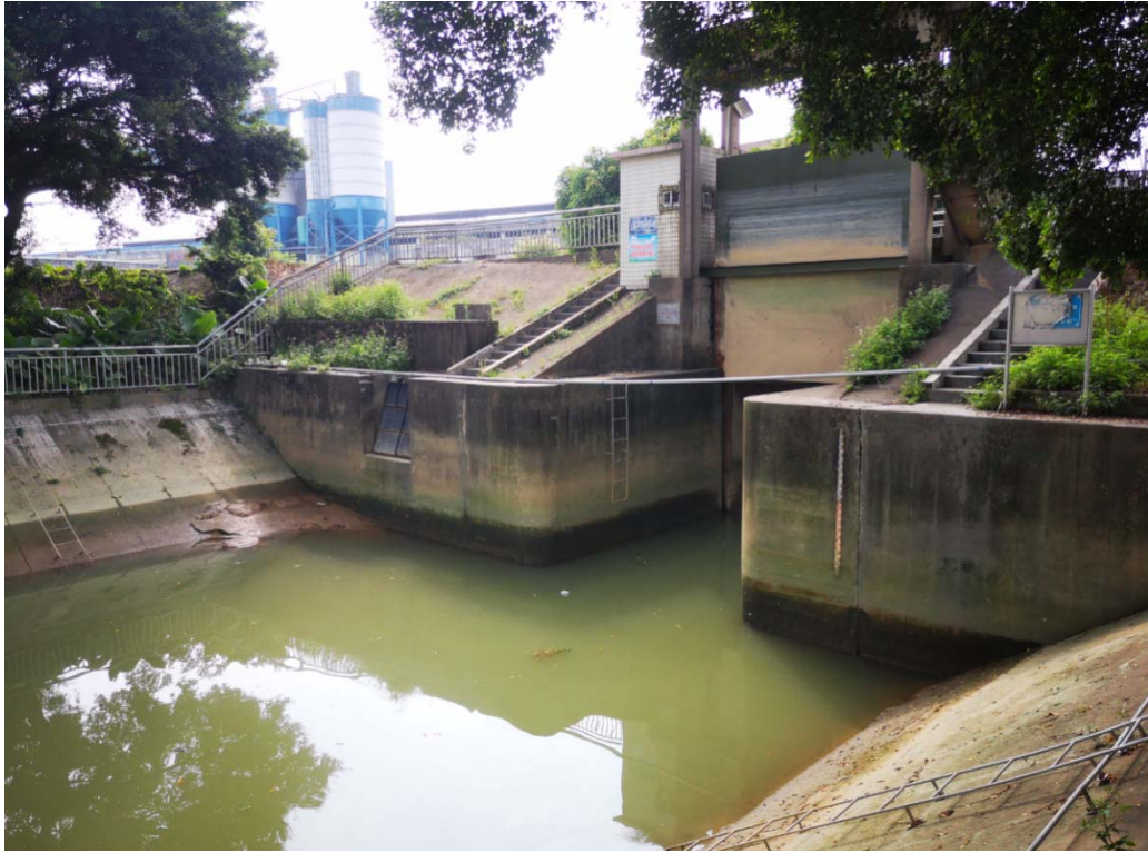
汲水泵站水闸外江侧
