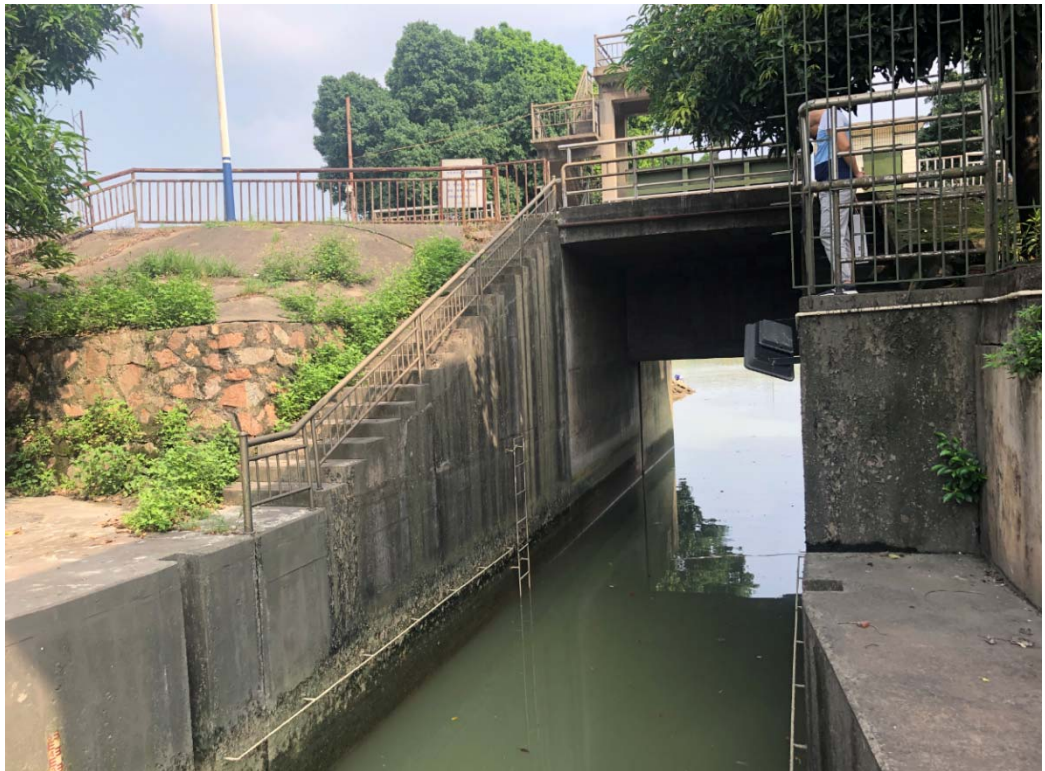
汲水水闸内河涌侧
