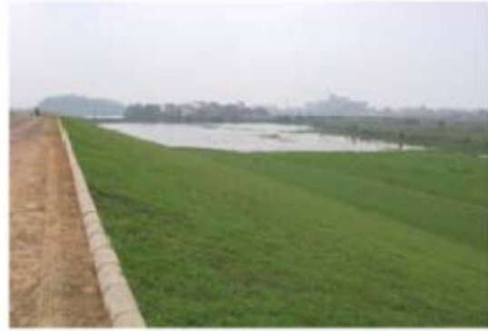
北江大堤施工结束效果图
