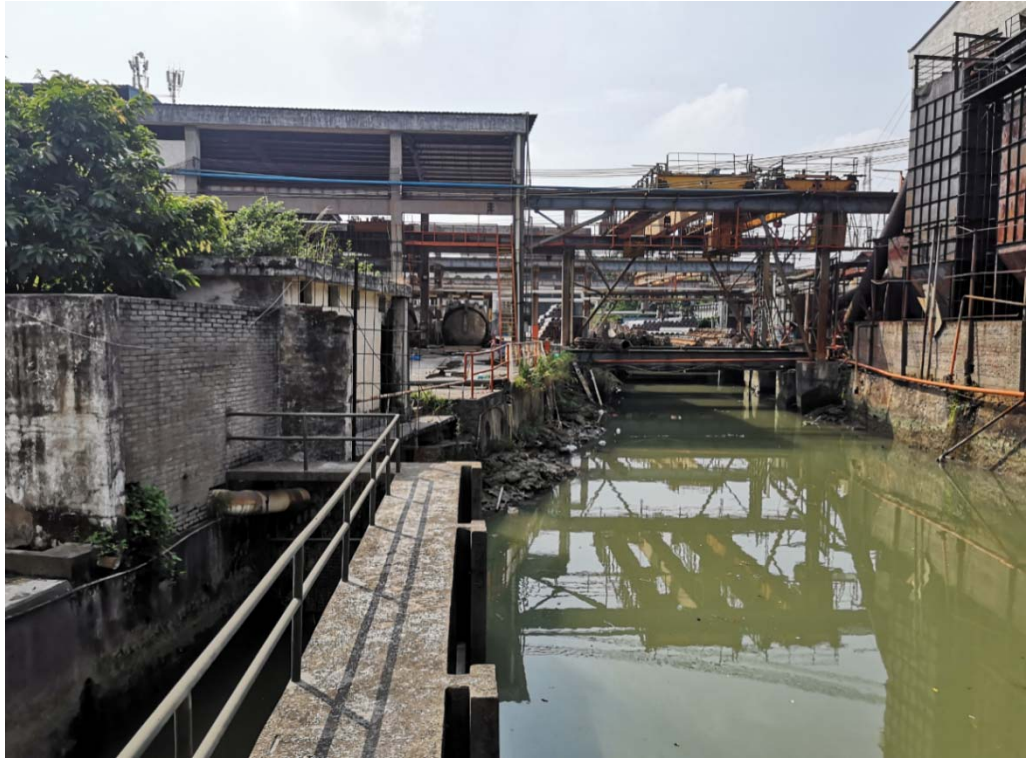
汲水泵站水闸内河涌连接段
