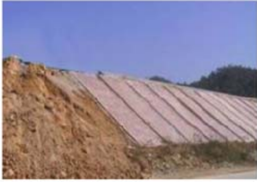
北江大堤施工期塑料薄膜防护
