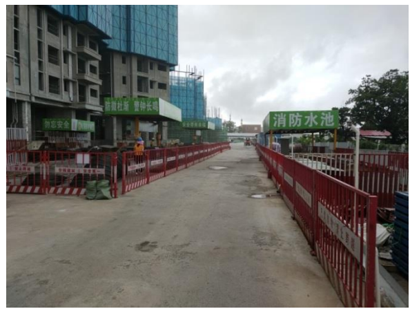
场地北侧施工现状
