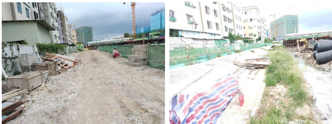
场地南侧施工现状
