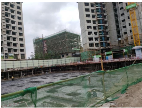
项目地下室结构及地上建设现状
