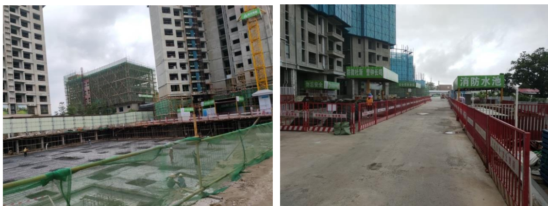
项目地下室结构及地上建设现状
