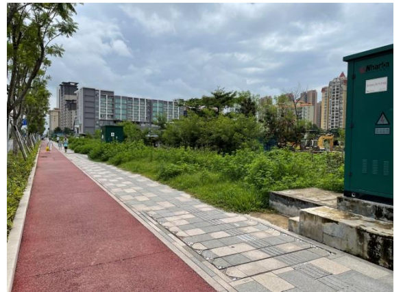
(路基临时占地区) 湖中东路
