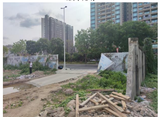
东北侧施工出入口
