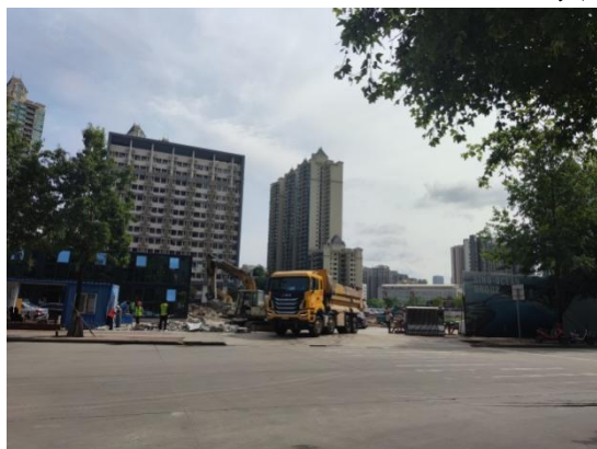
西南侧施工出入口
