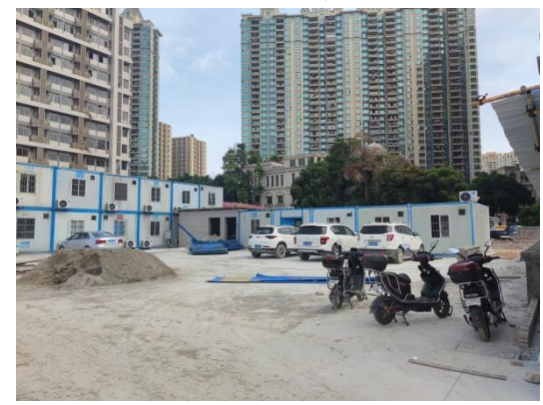
北侧施工临建区
