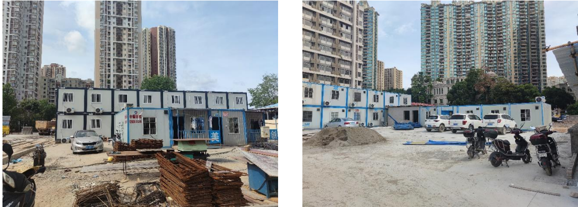
图 2-8 施工临建区情况图
