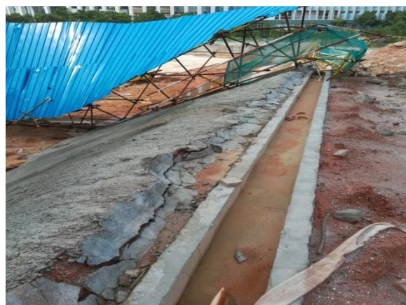
基坑顶部排水沟（2017.09）
