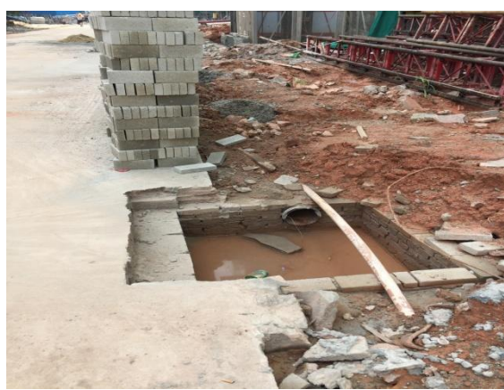
基坑顶部沉沙池（2017.09）
