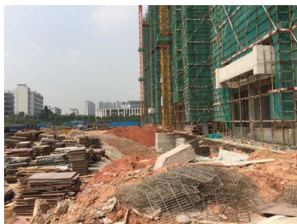
项目场地施工现状（2017.09）
