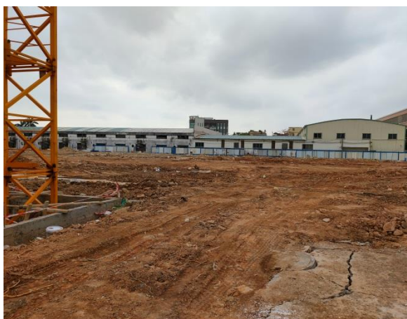
场地中部施工情况及围挡
