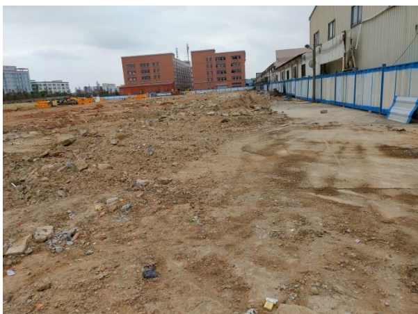
场地西南侧施工情况
