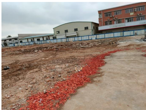
场地西北侧施工情况
