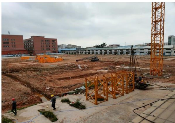
场地整体施工现状一
