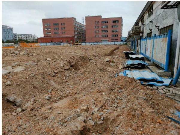
场地内施工现状
