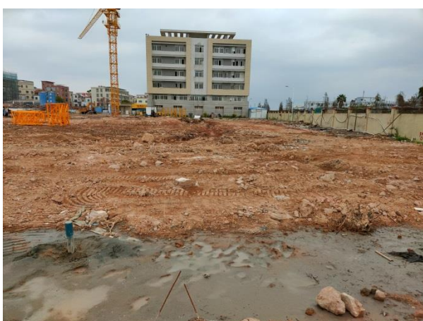
场地东侧施工情况
