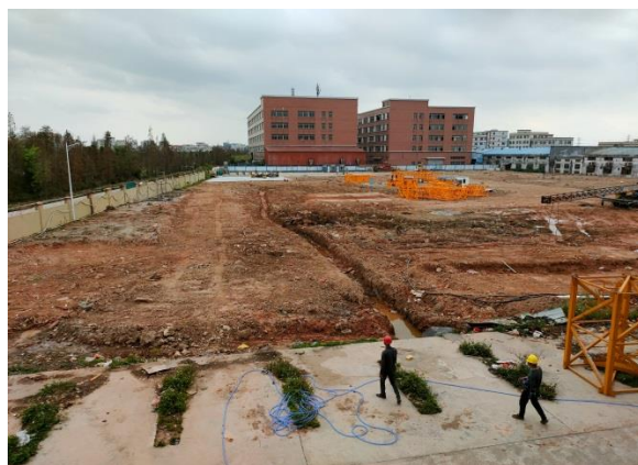
场地整体施工现状二
