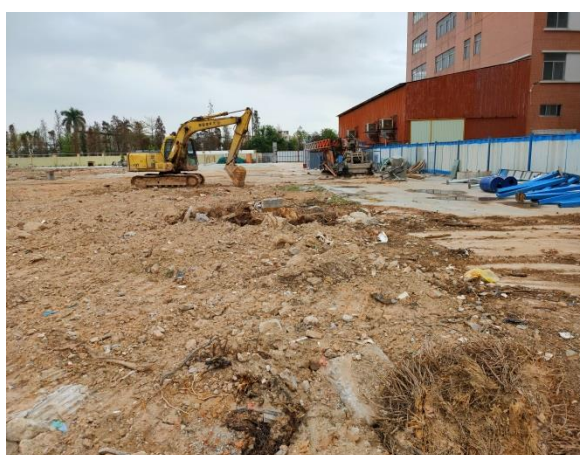
场地南侧施工情况
