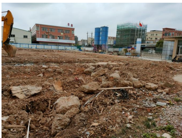
场地东侧施工情况
