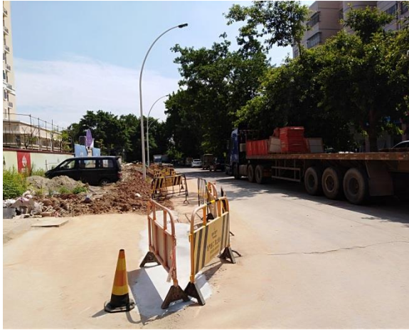
东侧道路现状
