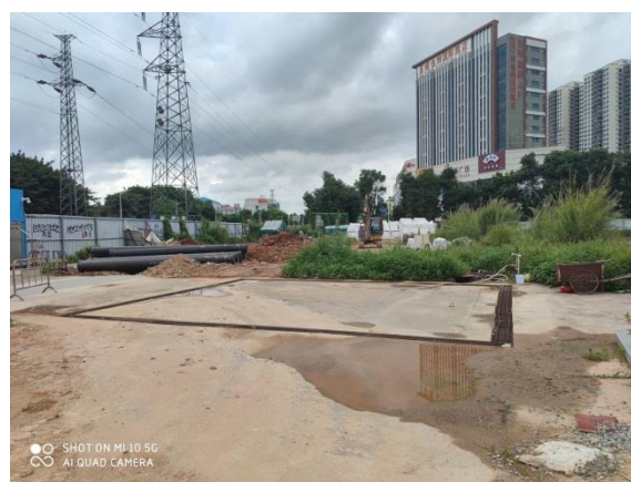
南侧施工出入口
