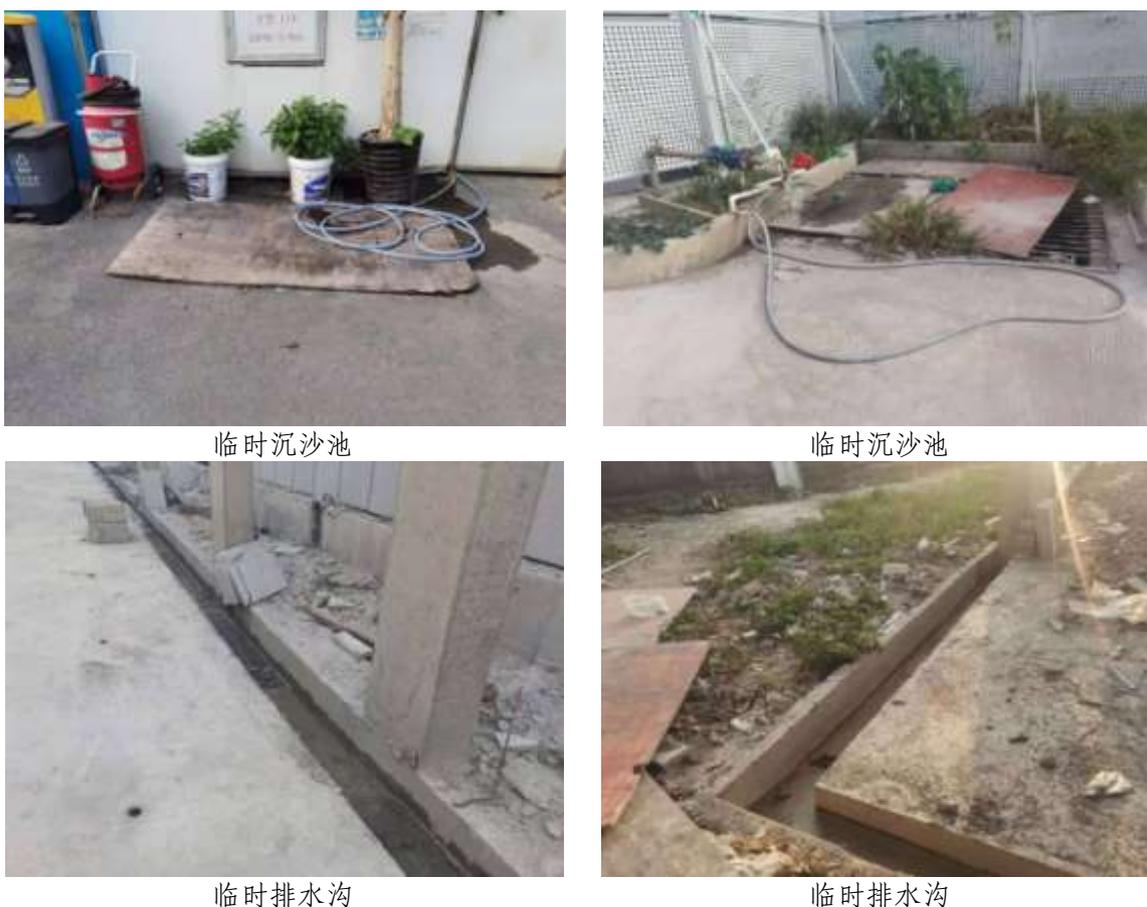
图 2-3 施工过程中排水设施图
