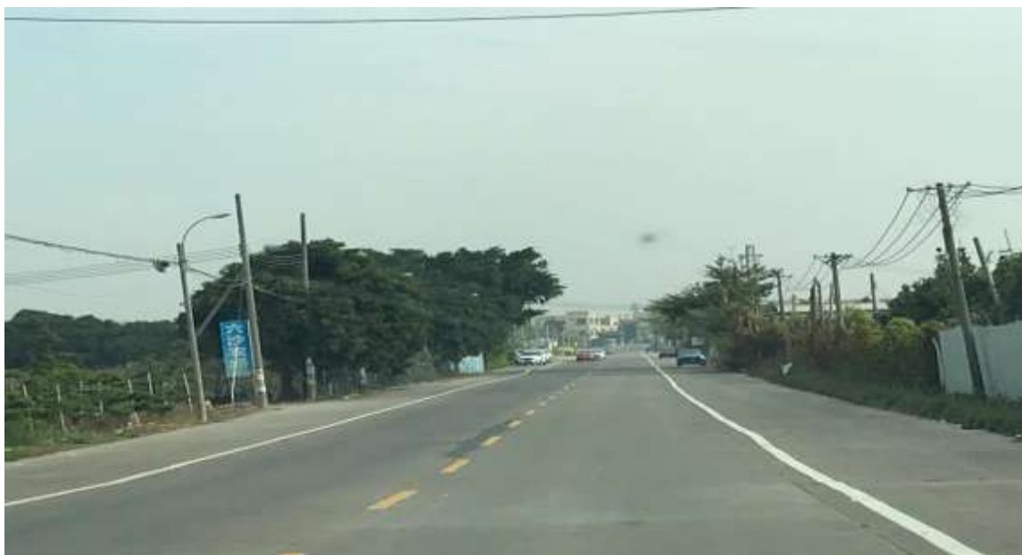
图2-3 六沙大道（西段）现场照片
