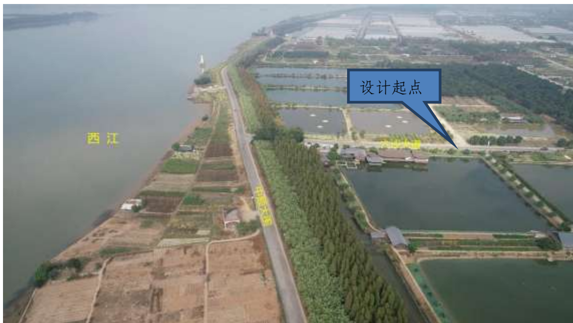
图2-2 稔益水厂及取水头部现状照片
