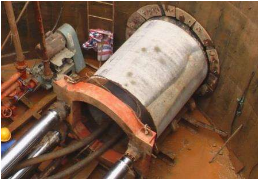
图2-31 顶管施工现场图片
