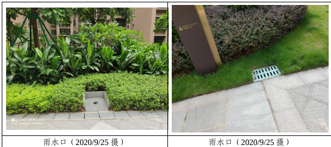
图 4-1 水土保持工程措施照片
