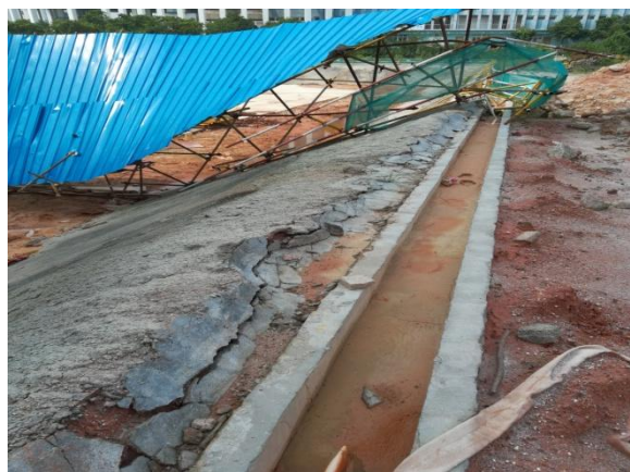
基坑顶部排水沟（2017.09）
