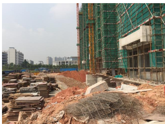
项目场地施工现状（2017.09）
