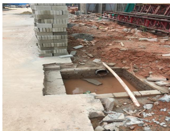
基坑顶部沉沙池（2017.09）
