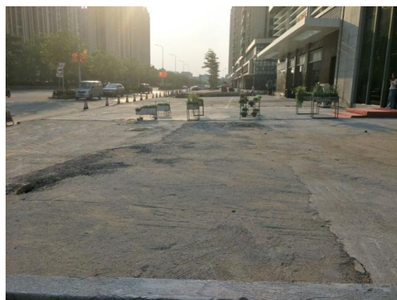
南侧硬化路面
